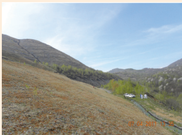
Vista parziale del versante settentrionale del sito Lato Corio - Sistemazione statica, idrogeologica e idraulica
