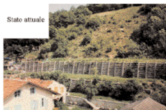
Figura 6.22 - Il versante a 3 anni dalla ultimazione dell'intervento di sistemazione
