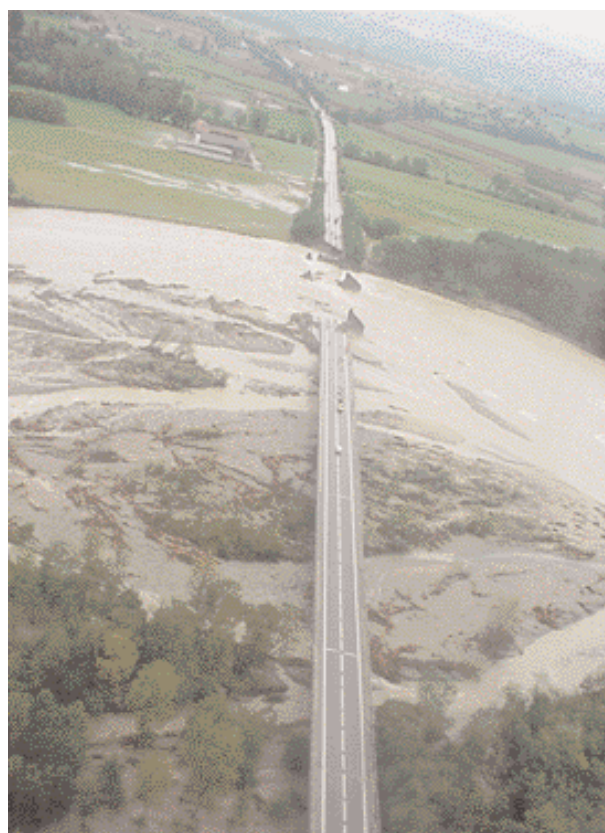
Figura 6.27 - Ponte della Pedemontana asportato dal T. Orco
