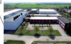
Impianto FN-SO.G.I.N. Fabbricazione di combustibile nucleare
