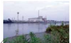
Centrale E. Fermi-SO.G.I.N. Impianto di potenza
