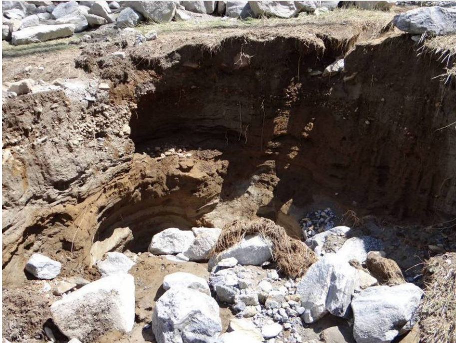
Figura 15. Cavità di erosione dovuta all'acqua disalveata e ad alta velocità, presente nella zona d'unghia del conoide alluvionale: è evidente la stratificazione di sabbie e piccoli ciottoli tipici dei depositi in posizione distale. Foto Arpa Piemonte 13/06/2019.
