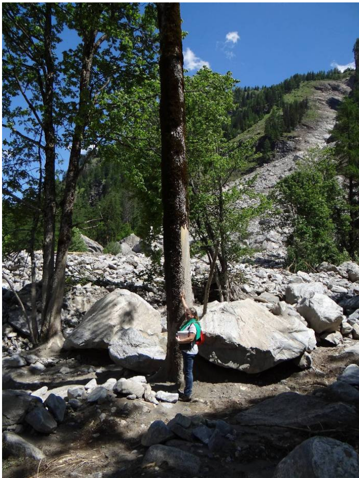
Figura 17. Lo scorticamento del tronco d'albero permette di stimare un'altezza di circa 3.30 m raggiunta dalla colata detritica del ramo in sinistra idrografica. Foto Arpa Piemonte 13/06/2019.
