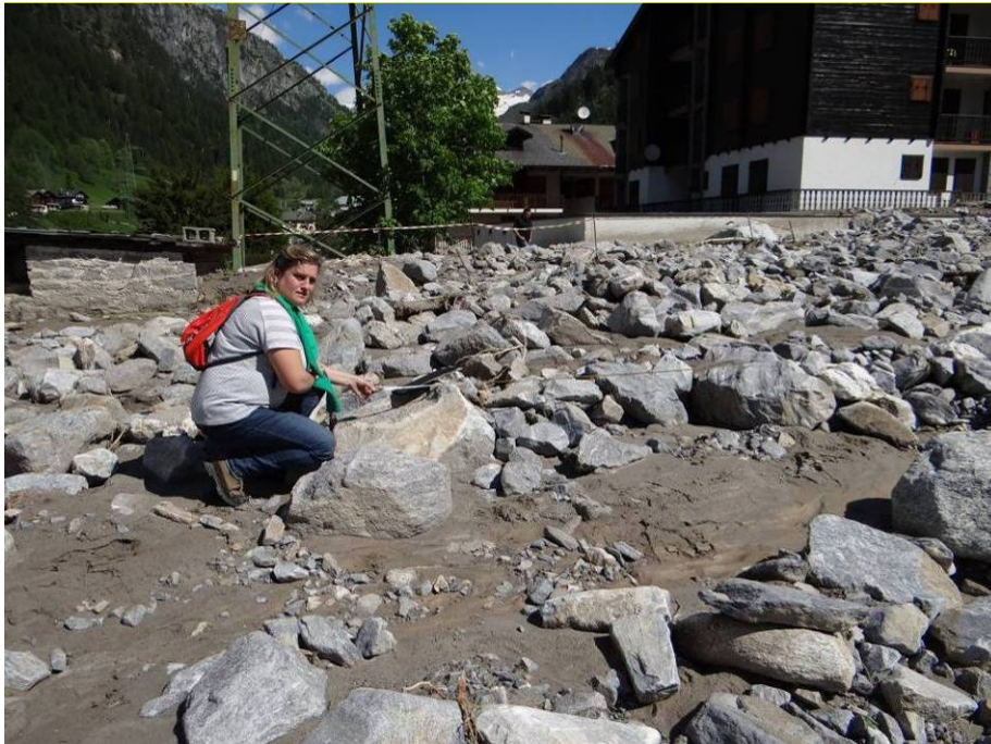
Figura 13. Depositi nella parte terminale del conoide alluvionale costituiti da blocchi e ciottoli immersi in una matrice sabbiosa-limoso. La parte più fine argillosa è stata dilavata durante la fase finale dell'evento. Foto Arpa Piemonte 13/06/2019.
