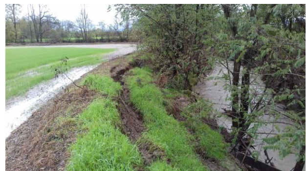
Figura 34. Tracimazioni del Grue a monte di C.na Capitania e direzione di esondazione (a sinistra); si notano tracimazioni ed erosioni spondali (a destra)
