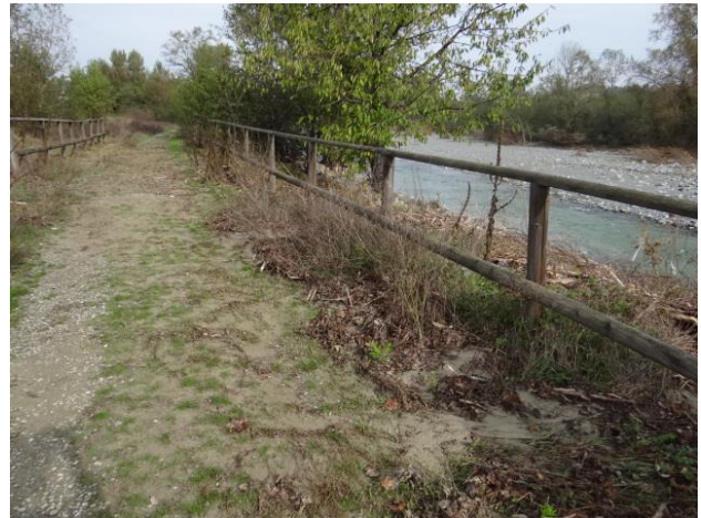
Figura 41. Belforte: danno alla difesa spondale in corrispondenza con la traversa (a sinistra); piano della ciclopedonabile in sponda sinistra con tracce di allagamento (a destra)
