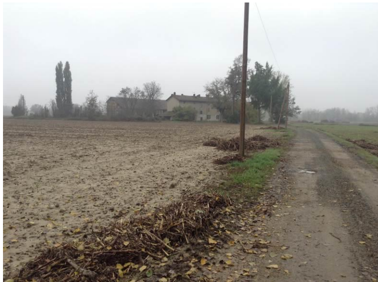
Figura 11. Bosco Marengo: aree inondate dal T. Orba in corrispondenza di C.na Marchesina. Il muro arginale che circonda il perimetro meridionale della cascina ne ha impedito allagamenti significativi. L'Orba è in secondo piano, oltre la cascina. Deflussi verso destra
