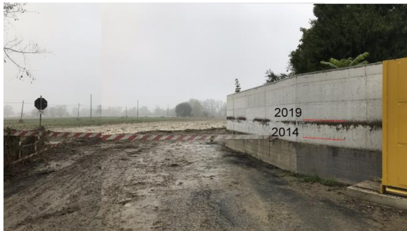
Figura 2. Concentrico di Capriata d'Orba, confronto tra le altezze delle inondazioni del 2014 e del 2019. A sinistra l'attraversamento di uno dei canali che hanno convogliato verso valle le portate dell'Albedosa e dell'Orba; in primo piano, sommerso da uno strato di fango, il piano viario di strada Oltreorba
