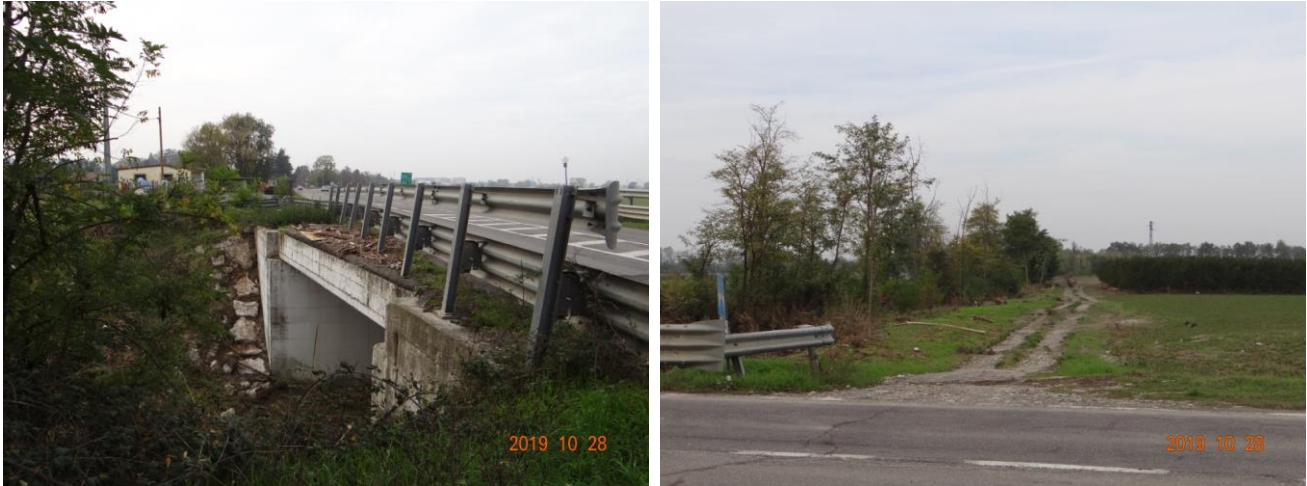
Figura 31. Sormonto dell'attraversamento della SP99 (a sinistra); nei campi a valle del ponte tronchi lasciati dalle acque che hanno invaso i campi (a destra)
