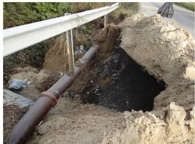
Figura 23. Gavi, via Parodi: allagamento da esondazione di un rio senza nome, con deposito di materiale fine (a sinistra); località Masseria Mignona: danno all'attraversamento di un rio senza nome, con deposito di materiale fine (a destra)
