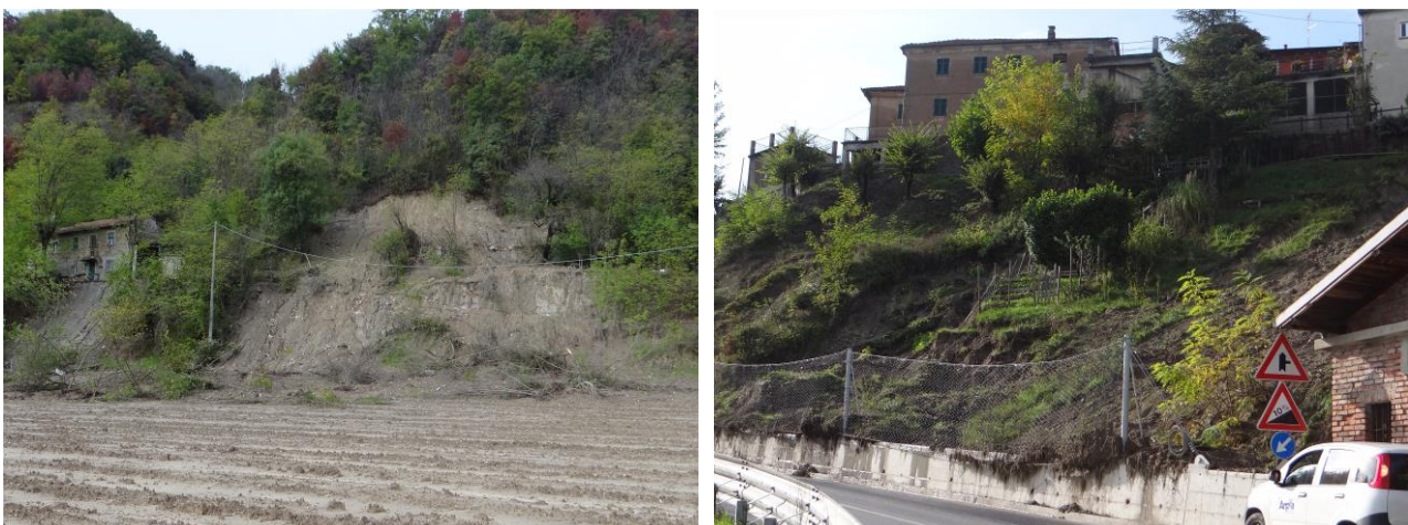
Figura 49. Gavi: rimobilizzazione di terreni di copertura (a sinistra); Serravalle Scrivia, borgata Crenna Superiore: scivolamenti di terreni superficiali sul substrato (a destra)
