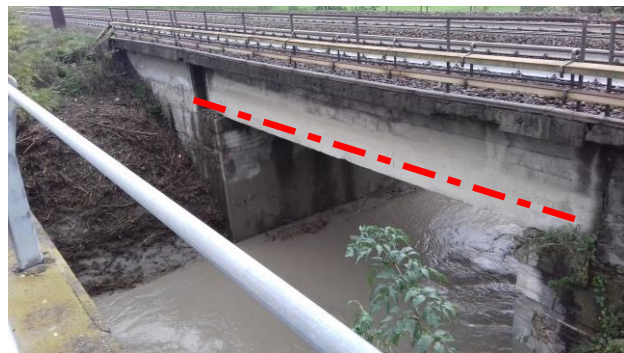
Figura 36. Sottopasso alla SR 10 del rio Calvenza (a sinistra); impalcato della ferrovia raggiunto dalle acque del Grue in piena. La linea tratteggiata ne indica l'altezza stimata (a destra)
