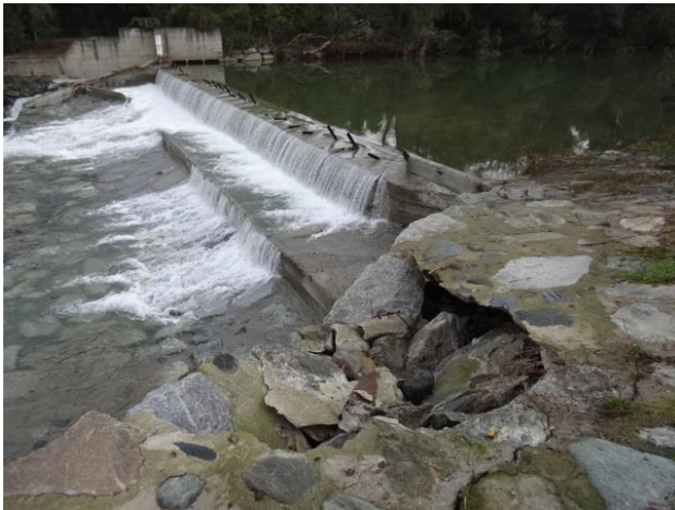
Figura 41. Belforte: danno alla difesa spondale in corrispondenza con la traversa (a sinistra); piano della ciclopedonabile in sponda sinistra con tracce di allagamento (a destra)
