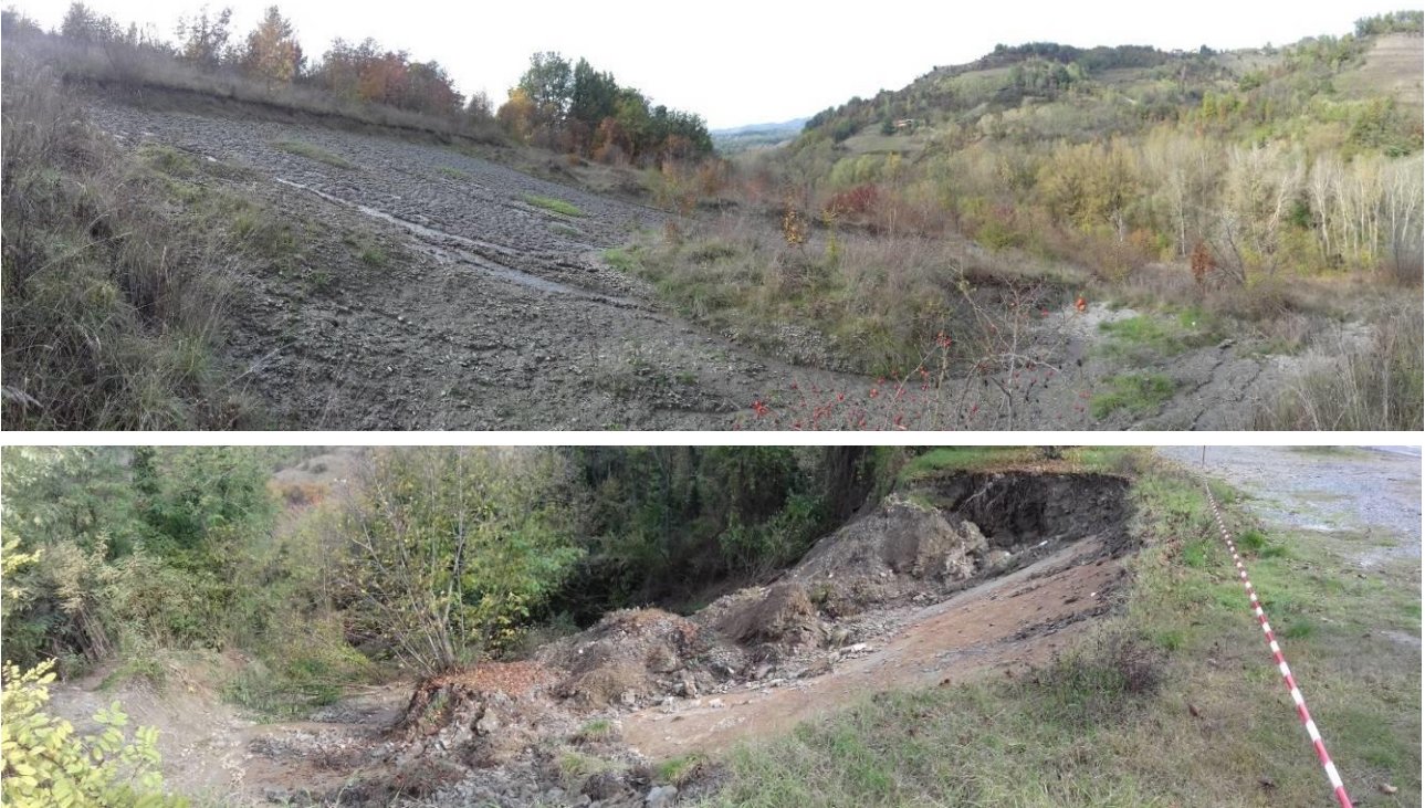
Figura 53. Esempi di scivolamento planare nei comuni di Lerna e Parodi Ligure
