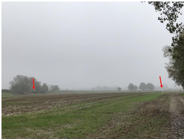
Figura 9. Rotte arginali dell'evento del 2019 (indicate dalle frecce). La rotta in secondo piano è ubicata circa in corrispondenza di quella del 2014
