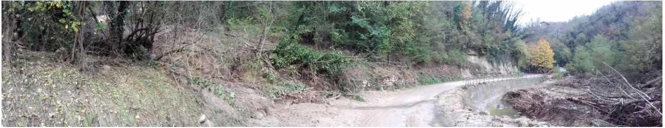
Figura 56. Esempi di danno da erosione di sponda, di fondo, da sovralluvionamento e da rimobilizzazione di corpo di frana in alveo durante piena del rio
