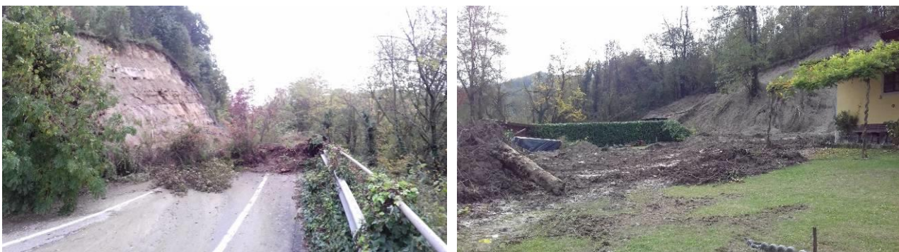
Figura 51. Ovada e Castelletto d'Orba: esempi di fluidificazione di coltre superficiale passante a colata estremamente fluida
