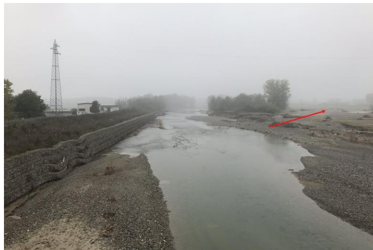
Figura 7. Torrente Lemme ripreso dal ponte della SP 155. La freccia indica un punto di esondazione. La gabbionata in sinistra ha subito deformazioni per erosione di fondo per piene successive alla costruzione dell'opera (dopo l'evento del 2014). Nel 2014 la piena del Lemme aveva traccimato il rilevato della SP 155. Durante l'evento del 2019 le inondazioni sono rimaste contenute entro l'argine (in secondo piano in direzione della freccia)
