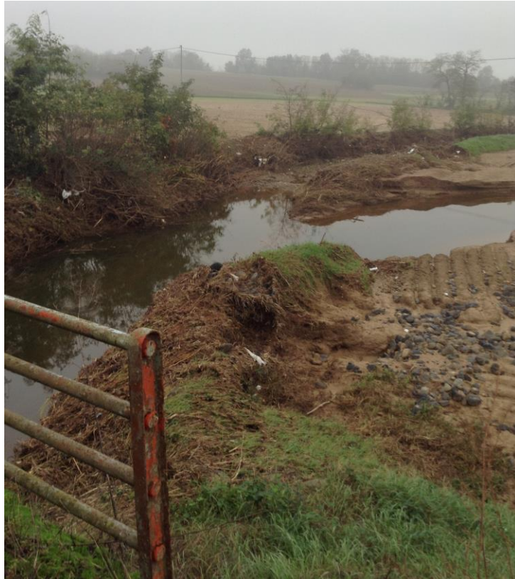
Figura 12. Forti erosioni operate dal Rio Cervino in corrispondenza dell'attraversamento della SP 180, al confine tra Bosco Marengo e Fresonara
