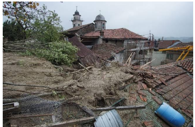
Figura 58. Frane superficiale sul versante a monte dell'Oratorio dei Turchini (a sinistra); danni al tetto dell'Oratorio dei Turchini (a destra)
