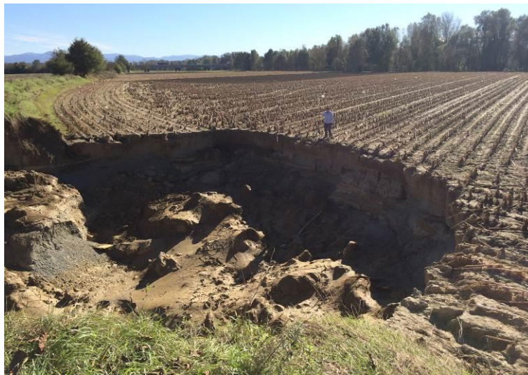
Figura 8. Rotta arginale del 13/10/2014. Vorragine prodottasi a monte. del rilevato asportato
