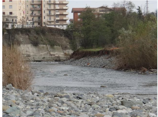
Figura 43. Ovada: sponda destra erosa in corrispondenza di Via Voltri (a sinistra); sponda destra erosa in corrispondenza di Via Voltri (a destra)
