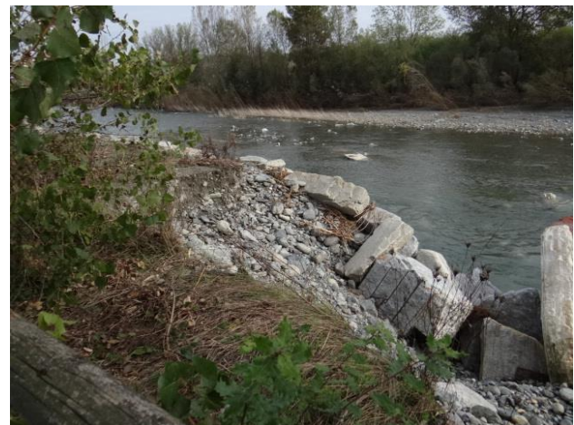
Figura 42. Materiale abbandonato dall'acqua fuoriuscita da un rio laterale in sponda sinistra (a sinistra); sponda sinistra a monte della rotonda tra SP456 e Via Voltri, difesa danneggiata (a destra)
