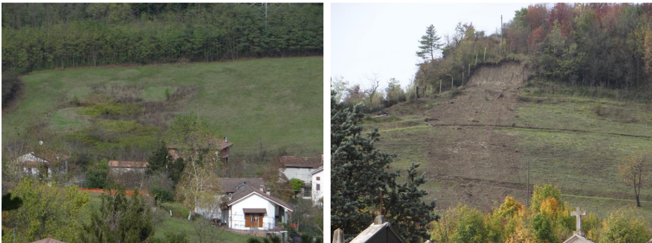
Figura 48. Traslazione di porzioni della coltre superficiale ( soil-slide ) tra Pratlungo e Arquata Scrivia (a sinistra); Gavi, fluidificazione di coltre superficiale evoluta in colata estremamente fluida - disintegrating soil-slip (a destra)
