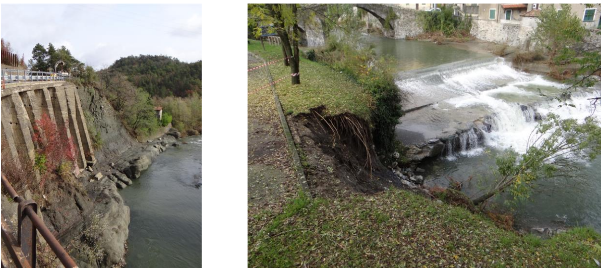
Figura 47. Erosione di sponda sul torrente Lemme (a sinistra); Erosione di sponda nei pressi di Voltaggio (a destra)
