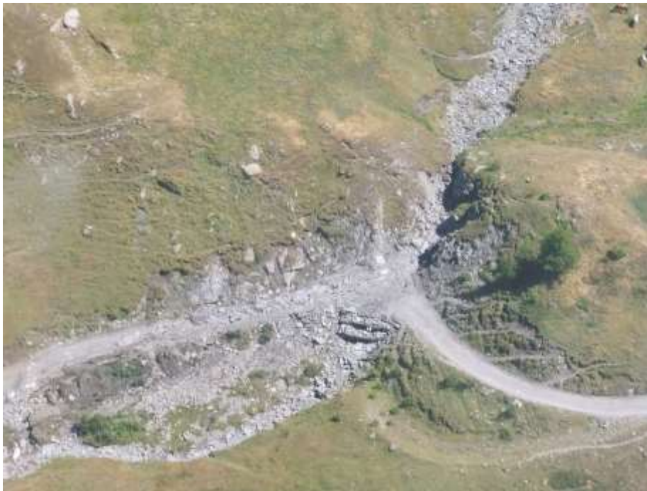
Figura 57 – Verso monte, si sono prodotte piccole colate dal versante destro, fino nel vallone del Gran Miol, con limitati coinvolgimenti della strada carrozzabile: in figura (foto CFAVS) l'attraversamento del rio Clot della Sagne, a 2220m di quota (DX12 in Figura 46).
