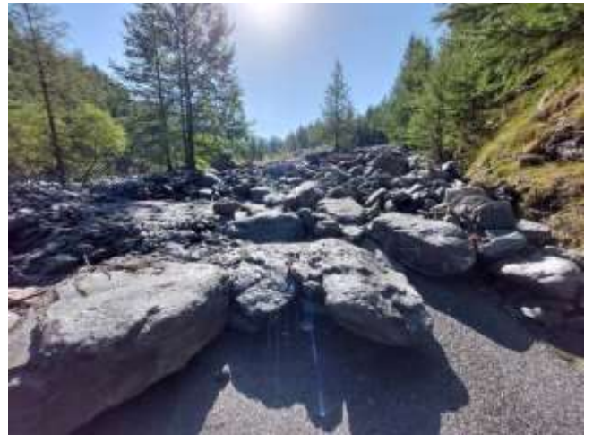
Figura 53 – Vallone Vallonet, versante sinistro della Valle Argentera, al margine inferiore della piana delle Brusa (SX9 in Figura 46): l'accumulo del materiale detritico in alveo ha determinato un temporaneo sbarramento del corso del torrente Ripa (a sinistra, foto CFAVS) mentre poco a monte, all'intersezione con la strada comunale ha determinato l'asportazione dell'attraversamento del rio Vallonet e abbondante deposizione di materiale ai fianchi (a destra, foto CFAVS).
