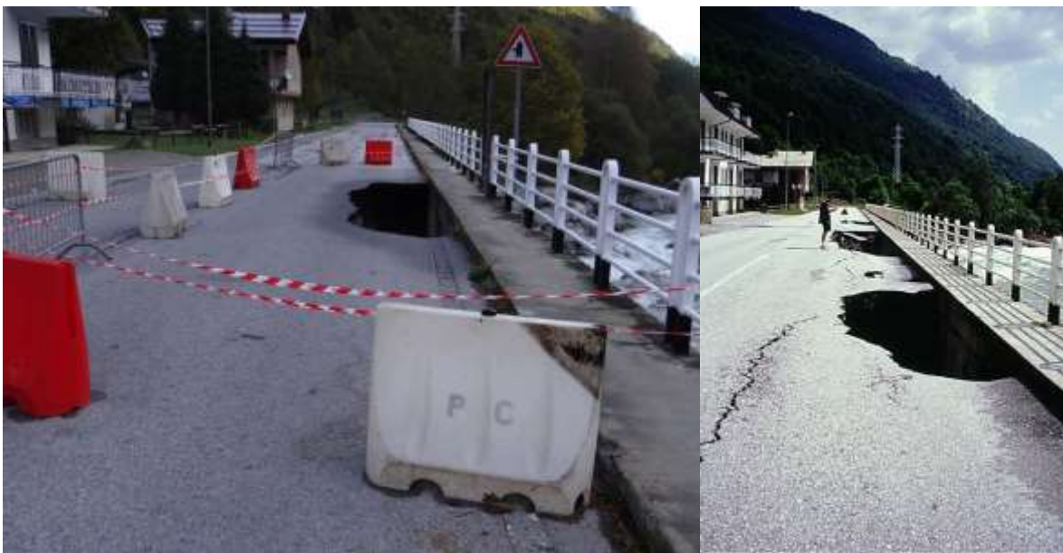
Figura 36 – Valdieri: sifonamento del muro in c.a. lungo la SP 239 in località Sant'Anna di Valdieri nel 2023 (alto e basso a sx) e nel 2000 (basso a dx)
