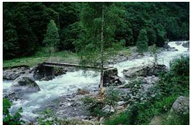
Figura 35 – Valdieri: erosione degli accessi all'impalcato del Ponte della Vagliotta nel 2023 (alto), nel 2020 (basso a sx) e nel 2000 (basso a dx)
