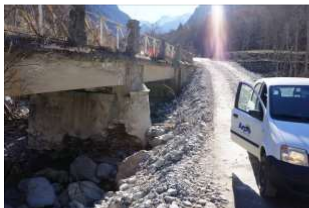
Figura 39 – Entracque: guado asportato sul Rio Bucera (in alto foto del 23 ottobre 2023 di Filippo Fulcheri); ripristino del guado nel 2023 (basso a sx), ponte danneggiato e conseguente guado realizzato nel 2020 (basso a dx)
