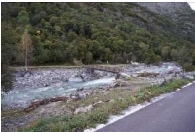
Figura 35 – Valdieri: erosione degli accessi all'impalcato del Ponte della Vagliotta nel 2023 (alto), nel 2020 (basso a sx) e nel 2000 (basso a dx)
