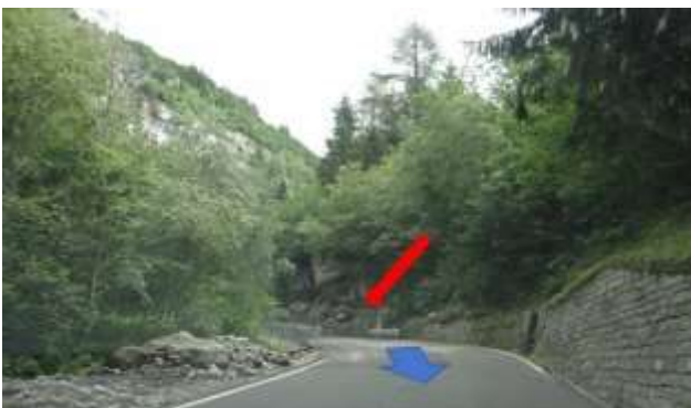
Figura 39 – Tratto di strada interessato dal materiale detritico anche di grossa pezzatura (a sinistra), ricostruzione del processo, la linea rosso è il canale in cui è transitato il materiale detritico che si è depositato perlopiù sulla strada statale. Parte dell'acqua con materiale più fine ha seguito la strada superando il ponte e giungendo ai piedi del versante opposto (a destra).
