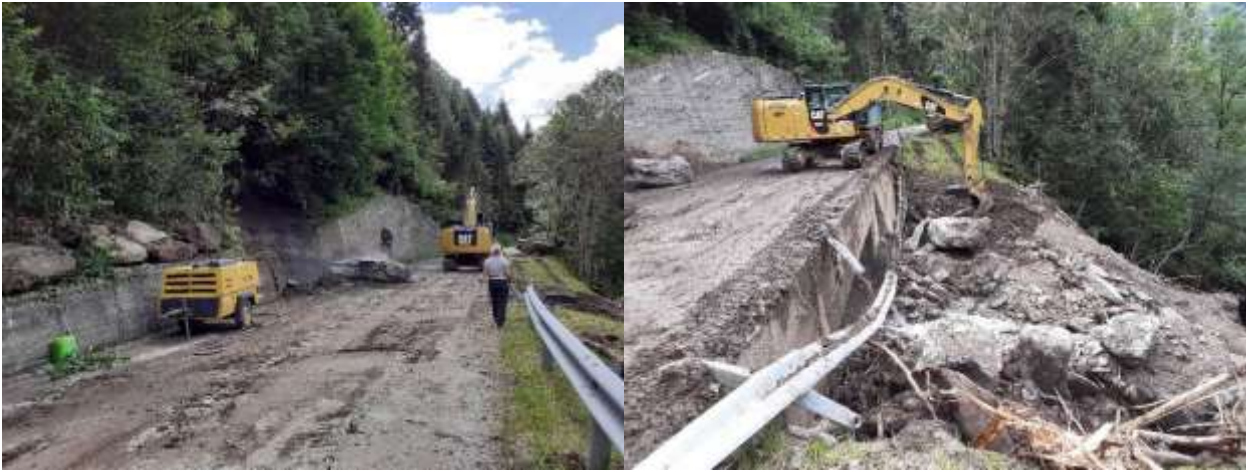
Figura 33 – Blocchi in fase di rimozione dalla sede stradale e dal sottopasso del rio Cugnesco.
