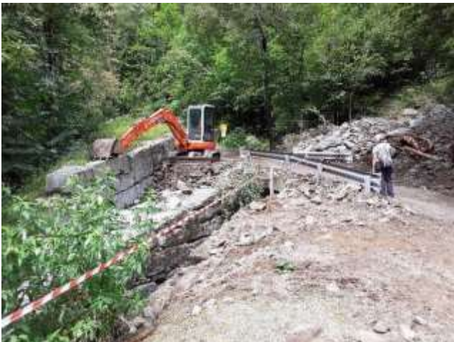
Figura 40 – Zona apicale del conoide dove si è generata la colata detritica: il materiale detritico di grossa pezzatura si è depositato sulla sede statale. Parte dell'acqua con materiale più fine ha seguito la strada raggiungendo la SS659, mentre parte della colata è transitata verso il fondovalle costeggiando il canale.
