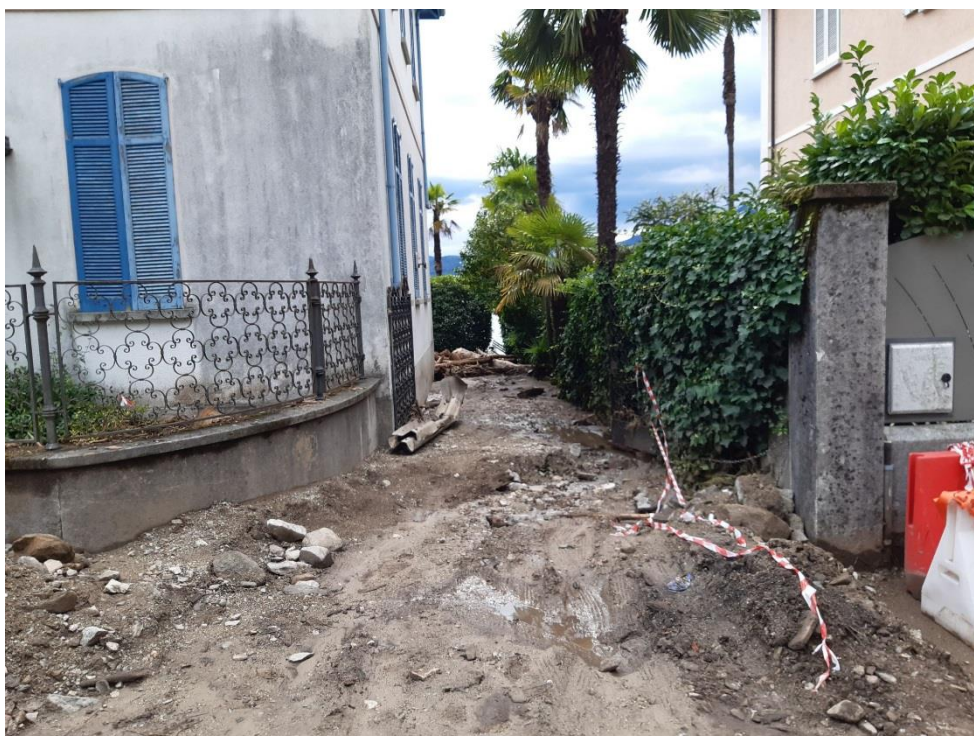
Figura 26: materiale più fine depositatosi sulla SS n° 34 e in prossimità delle case adiacenti
