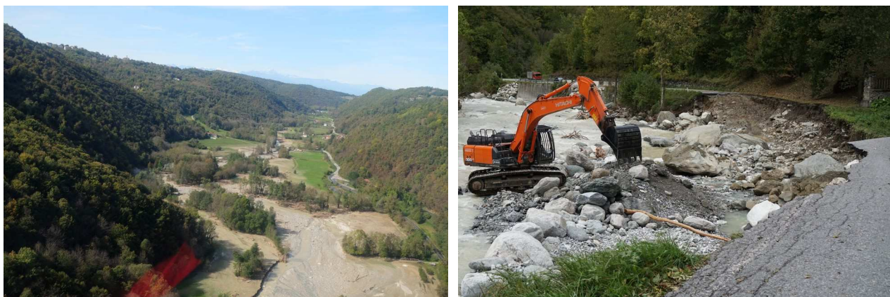
Figura 96 - San Michele Mondovì: Effetti dell'esonazione del T. Casotto sulle piane in loc. Tetti Casotto, a monte della confluenza con il T. Corsaglia (a sinistra); Roburent: erosione della sponda destra del T. Corsaglia a monte dell'omonima località con asportazione di un tratto della strada di fondovalle (a destra).
