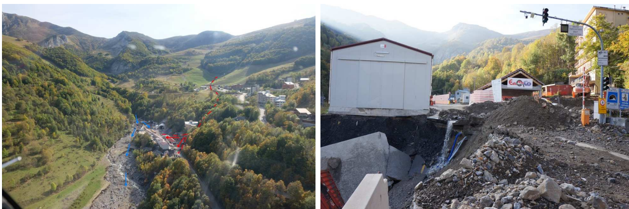
Figura 85 - Limone P., area di imbocco del tunnel di Tenda: in rosso la dinamica del rio proveniente da Quota 1400 e in blu l'attività del rio del Vallone Cabanaira (a sinistra); il materiale detritico trasportato dal rio proveniente da Quota 1400 e la scarpata della frana che ha coinvolto le infrastrutture del cantiere (a destra).
