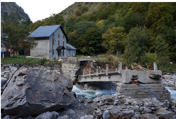
Figura 91 - Valdieri: ponte distrutto all'ingresso della località Terme di Valdieri dalla violenta attività torrentizia del Torrente Gesso della Valletta (a sinistra); ponte della Vagliotta parzialmente danneggiato dalle acque del Torrente Gesso della Valletta per erosione della sponda destra (a destra).
