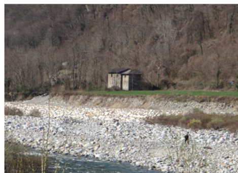
Profonda erosione in sponda destra, messa in posa alla base di difese spondali (2014).
