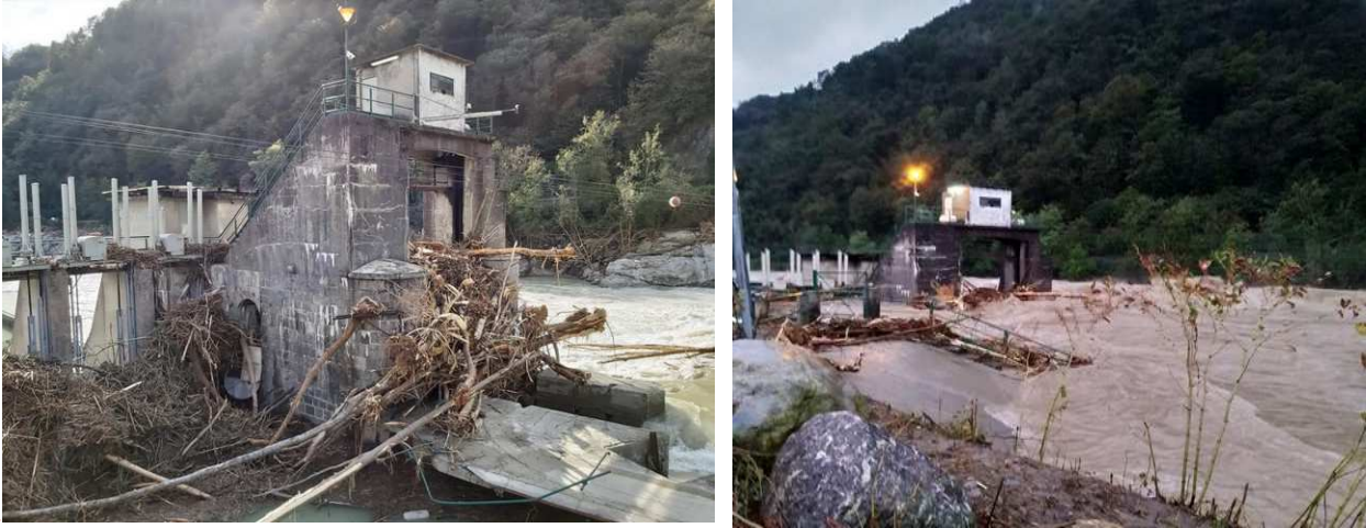
Figura 67 - Nella fotografia di sinistra i tronchi e arbusti trasportati dalla piena intrappolati negli organi di derivazione della traversa di Quarona dopo la piena. Nell'immagine di destra il fiume alle 8.00 della mattina di sabato 3 ottobre.
