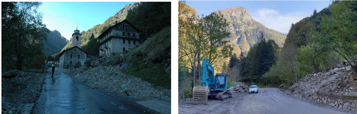
Figura 62 - Santa Maria, colata detritica all'ingresso della frazione (a sinistra); Rimasco, colata detritica sulla strada SP10 (a destra)
