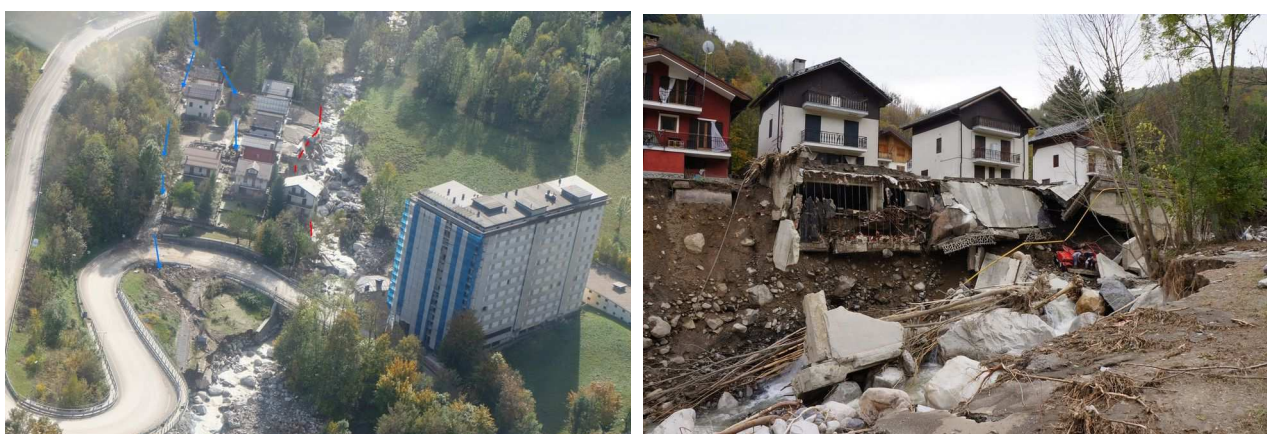
Figura 86 - Limone P., Villaggio Miramonti: in rosso l'erosione di sponda da parte del t. Vermenagna e in blu il flusso delle acque del rio Panice, fuoriuscite in apice di conoide (a sinistra); particolare dell'erosione di sponda (a destra).
