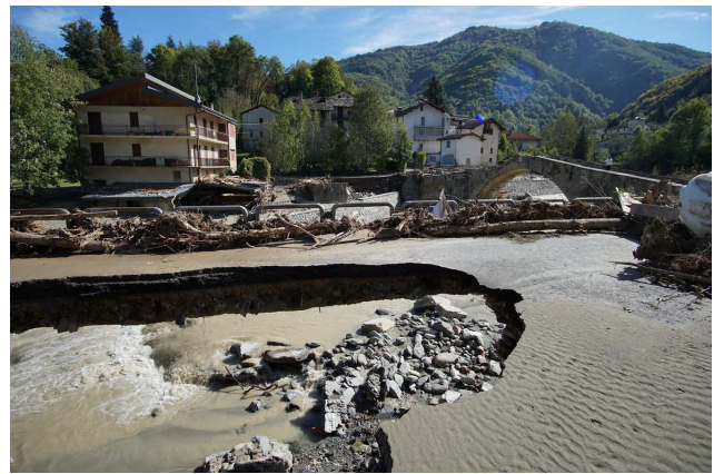
Figura 95 - Pamparato: panoramica da elicottero della parte dell'abitato di Pamparato più coinvolto dall'esondazione del T. Casotto (a sinistra); evidenti segni della violenta attività torrentizia del T. Casotto nell'abitato di Pamparato, in primo piano la strada provinciale sifonata e in secondo piano il ponte romano danneggiato.
