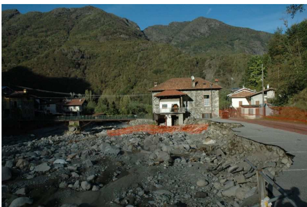
Figura 57 - Comune di Morca, edifici distrutti in sinistra idrografica a valle del ponte per il centro abitato (a sinistra); la piena del Rio Pianale e del T. Nono ha provocato l'asportazione di tre ponti sul rio Pianale tra Camasco e la frazione Corte e Costa (a destra).
