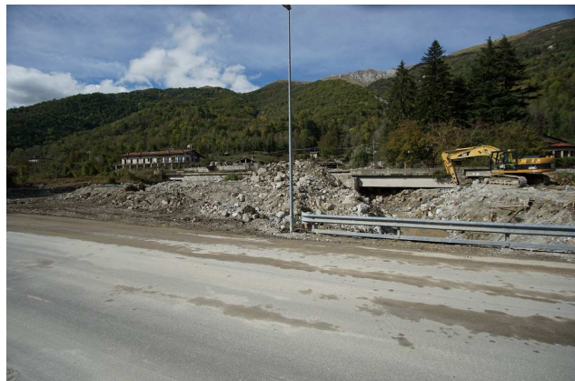
Figura 106 - Ormea: il ponte sul rio Armella è stato ostruito dall'abbondante materiale detritico e arboreo trasportato e le acque sono fuoriuscite defluendo lungo le due vie laterali al canale (a sinistra); rio Peisino: trasporto solido e deposito ai danni della ferrovia e della SS 28 (a destra).
