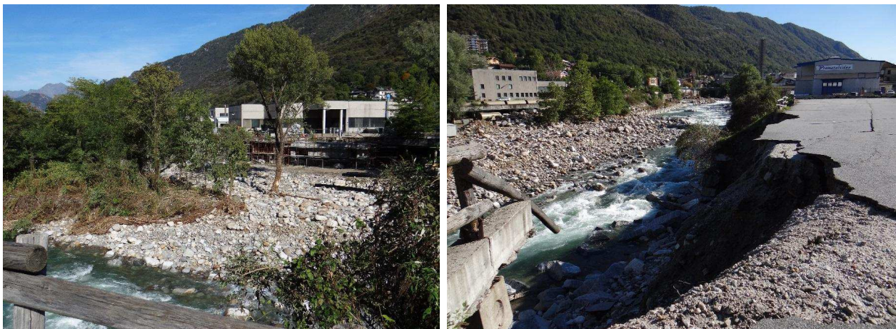
Figura 49 - Omegna, sponda destra erosa di fronte allo spaccio Lagostina (a sinistra), sponda sinistra erosa e cedimento della sede del parcheggio di fronte allo spaccio Lagostina (a destra).
