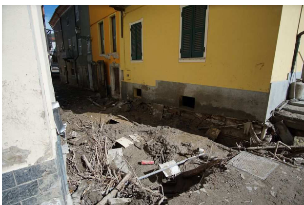
Figura 102 - Garessio: la piazza nei pressi del ponte Odasso è stata gravemente alluvionata a seguito dell'ostruzione e del sormonto del ponte stesso da parte delle acque in piena (a sinistra); anche le vie circostanti il ponte Odasso sono
