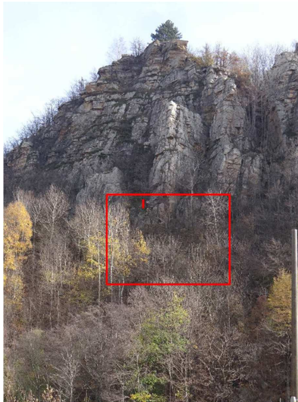
Figura 110 - Ormea, Ponte dei Sospiri: panoramica ravvicinata della zona monitorata; il riquadro rosso indica in modo approssimativo la zona instabile, il tratto rosso pari a circa 2 metri fornisce le proporzioni del fenomeno
