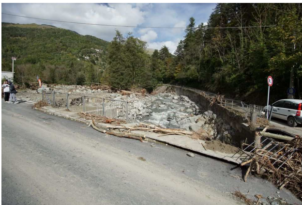
Figura 106 - Ormea: il ponte sul rio Armella è stato ostruito dall'abbondante materiale detritico e arboreo trasportato e le acque sono fuoriuscite defluendo lungo le due vie laterali al canale (a sinistra); rio Peisino: trasporto solido e deposito ai danni della ferrovia e della SS 28 (a destra).
