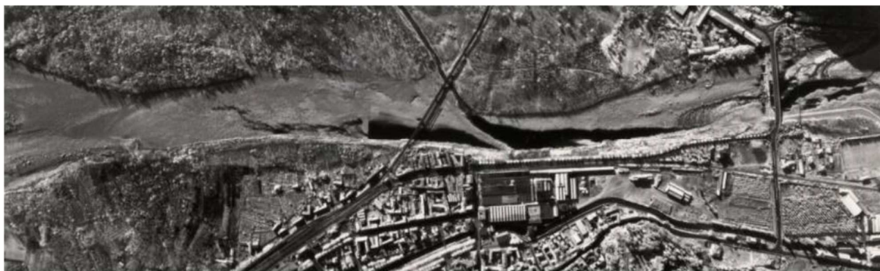
Figura 56 - In una fotografia aerea del 1971 sono visibili i segni lasciati da escavazioni in alveo a monte del ponte stradale e in prossimità di quello ferroviario. Il depauperamento del materasso alluvionale ha causato un repentino abbassamento del fondo alveo di 2 m dagli anni 70' con il progressivo ridursi della sezione.
