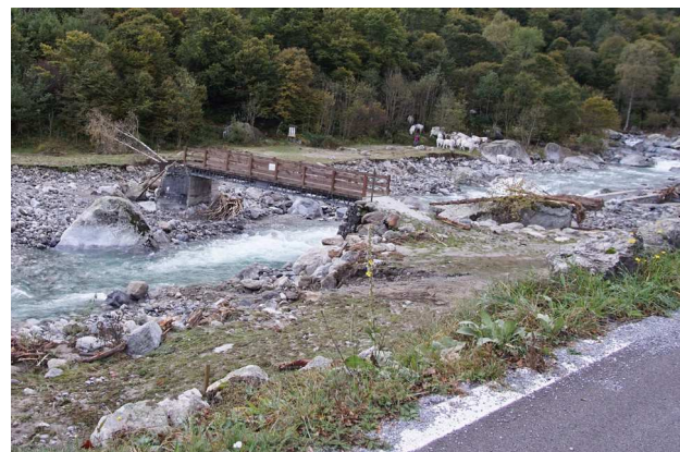
Figura 91 - Valdieri: ponte distrutto all'ingresso della località Terme di Valdieri dalla violenta attività torrentizia del Torrente Gesso della Valletta (a sinistra); ponte della Vagliotta parzialmente danneggiato dalle acque del Torrente Gesso della Valletta per erosione della sponda destra (a destra).
