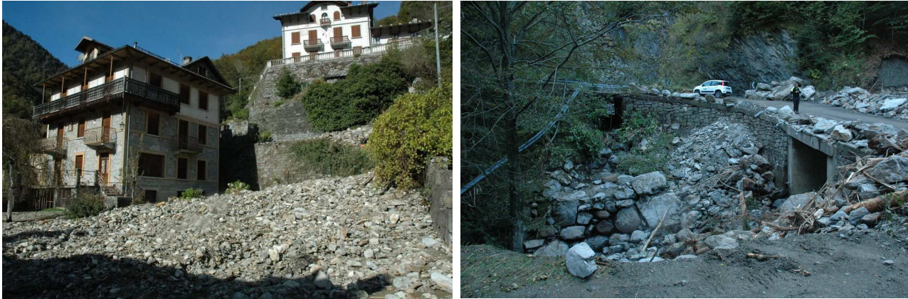
Figura 61 - Fobello, buona parte dell'abitato è stato interessato da una colata di detriti a granulometria medio-piccola e bassa energia); colata detritica sulla strada per Cervatto, a fianco del cimitero.
