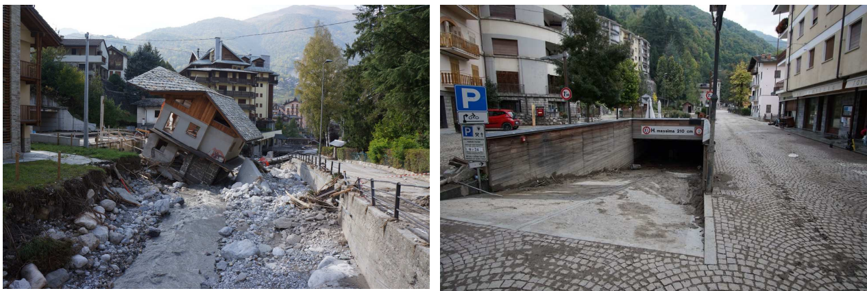
Figura 88 - Limone P., via Valleggia: l'intensa attività torrentizia del rio di San Giovanni ha causato gravi danni lungo il tratto urbano (a sinistra); piazza San Sebastiano: parcheggio sotterraneo totalmente sommerso dalle acque del t. Vermenagna (a destra).
