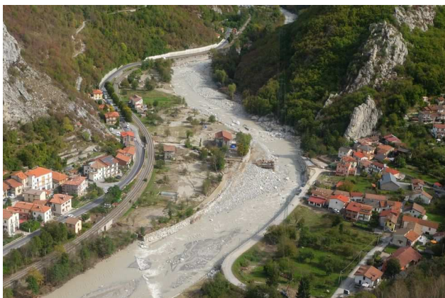
Figura 100 - Ormea, loc. Barchi: il ponte, ricostruito dopo l'alluvione del 1994, è stato completamente asportato dalla piena (a sinistra); Garessio, Cascina dell'isola: la piena ha occupato tutta la piana antistante la cascina con un'energia superiore a quanto avvenuto nel 2016, causando gravi danni agli edifici (a destra).
