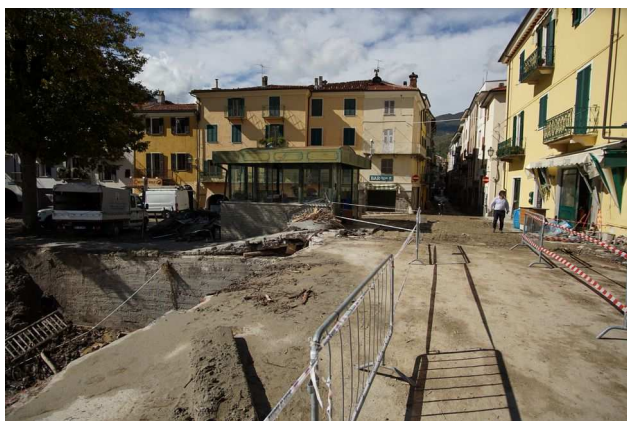
Figura 102 - Garessio: la piazza nei pressi del ponte Odasso è stata gravemente alluvionata a seguito dell'ostruzione e del sormonto del ponte stesso da parte delle acque in piena (a sinistra); anche le vie circostanti il ponte Odasso sono
