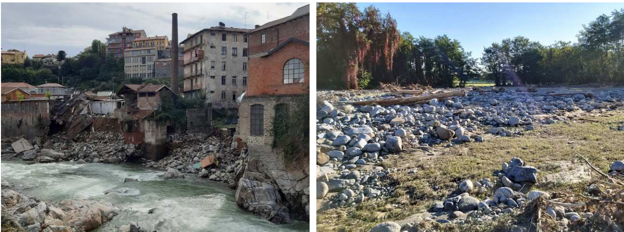
Figura 78 - Biella, crollo edifici di Cittadellarte (a sinistra); deposito materiale lapideo e ligneo a monte della traversa di derivazione (a destra).
