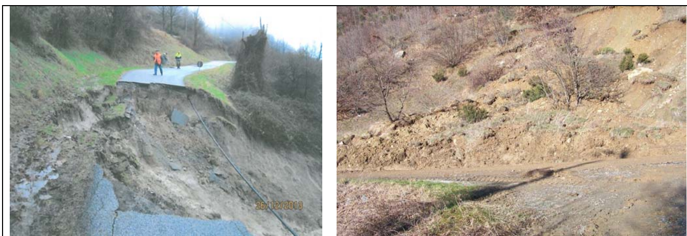
Figura 28. A sinistra, Comune di Fraconalto, interruzione della strada comunale Fraconalto-Tegli. A destra, Comune di Voltaggio Frana in strada Barca presso loc. Barchetta..
