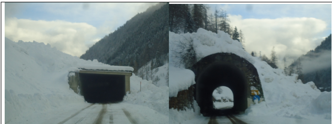
Figura 26. Valanghe cadute sulla strada provinciale di Carcoforo (Val Sermenza)
