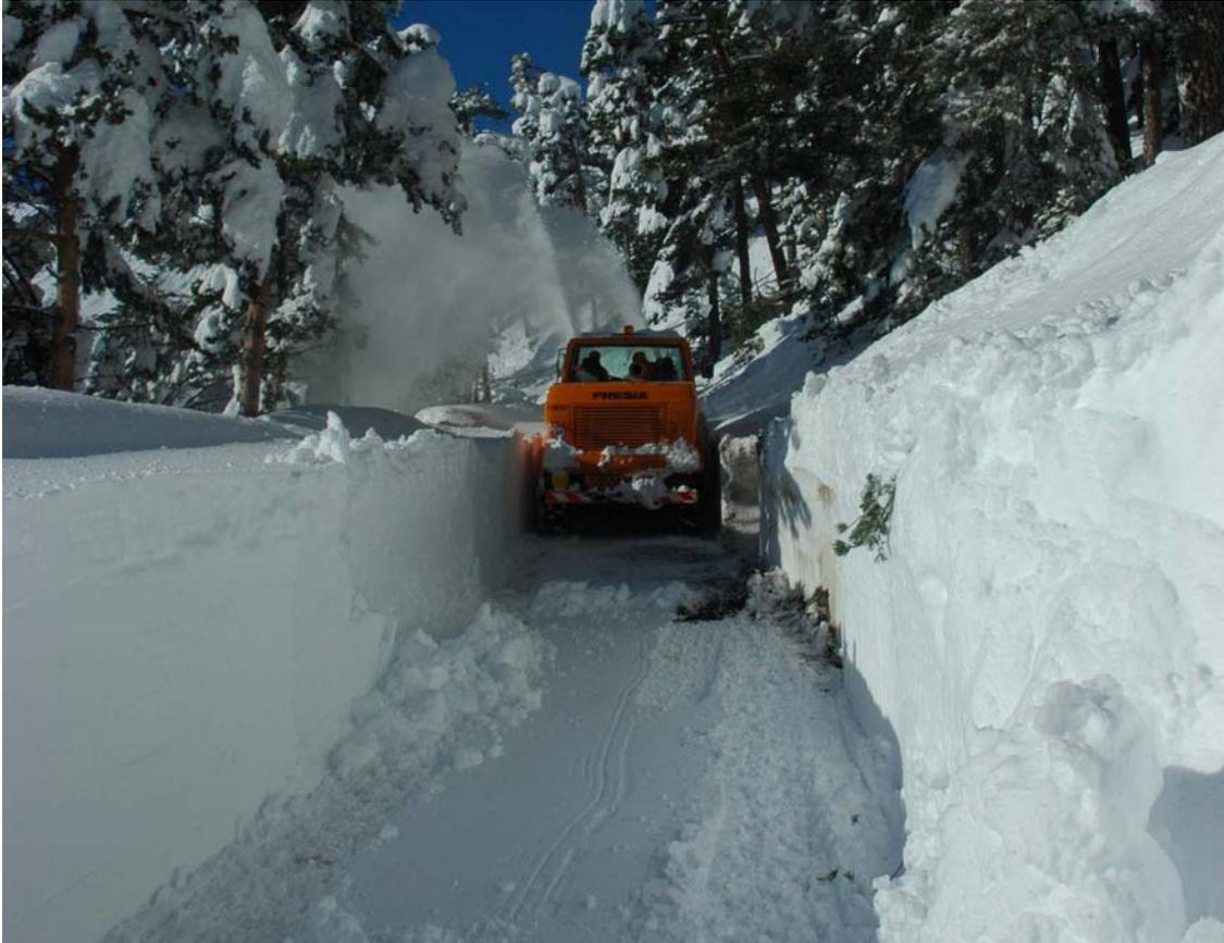
Figura 22. Operazione di sgombero neve per la riapertura delle strade
