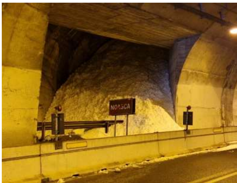
Figura 66 - Accumulo della valanga di “Balme Fiorant” (codice SIVA 31_E_TO) che entrando dalle aperture di valle del paravalanghe ha invaso parte della carreggiata. Foto del Parco Nazionale Gran Paradiso
