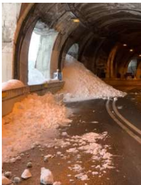
Figura 66 - Accumulo della valanga di “Balme Fiorant” (codice SIVA 31_E_TO) che entrando dalle aperture di valle del paravalanghe ha invaso parte della carreggiata. Foto del Parco Nazionale Gran Paradiso
