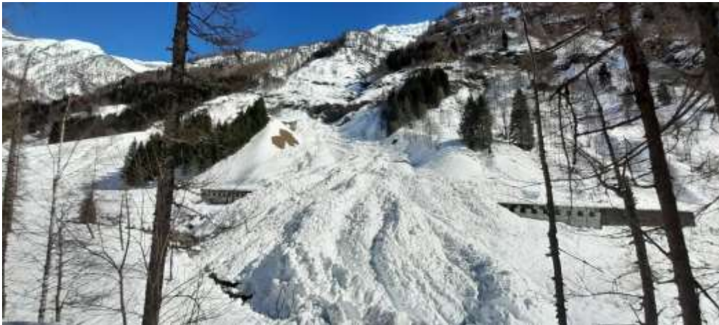
Figura 63 - Valanga del Pissone (codice SIVA: 04_B_VC); la galleria paravalanghe ha fortunatamente svolto al meglio la funzione protettiva. Foto effettuata durante i sopralluoghi svolti dalla CLV Val Sesia
