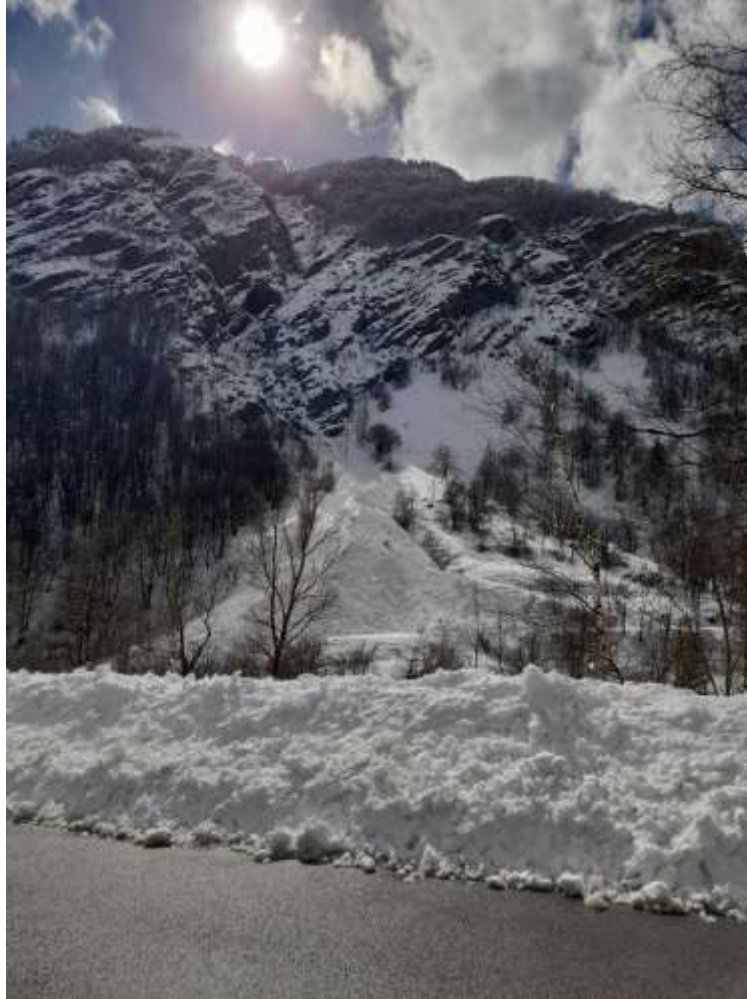
Figura 69 - Accumulo della valanga (codice SIVA 160_M_CN) scesa il 10 marzo, al termine della nevicata, nei pressi della località Pianche rimasta nella Stura senza interrare la strada statale 21. Foto effettuata durante i sopralluoghi svolti dalla CLV Valle Stura
