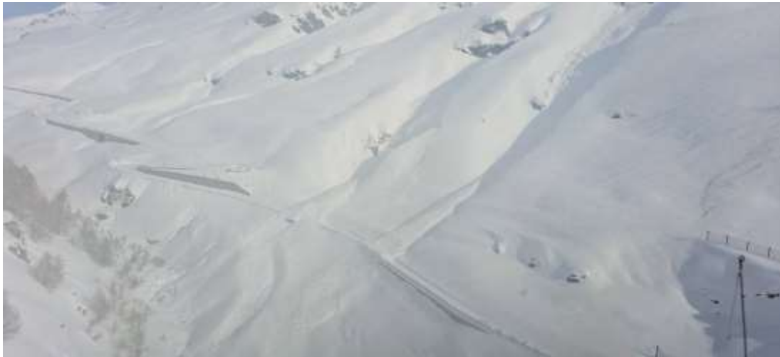
Figura 72- Valanghe che hanno interessato il tratto montano della SS 21 del Colle della Maddalena preventivamente chiuso al transito. Foto effettuata durante i sopralluoghi svolti dalla CLV Valle Stura
