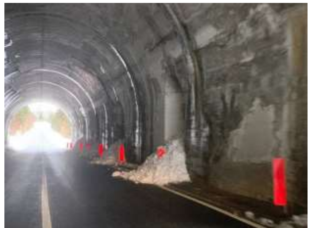
Figura 70 - Sulla sinistra è visibile la zona di accumulo della valanga (codice SIVA: 01_L_CN) che ha interessato la SS del colle della Maddalena protetta dal paravalanghe; sulla destra l'accumulo che è entrato dalle aperture di valle del paravalanghe. Foto effettuata durante i sopralluoghi svolti dalla CLV Valle Stura
