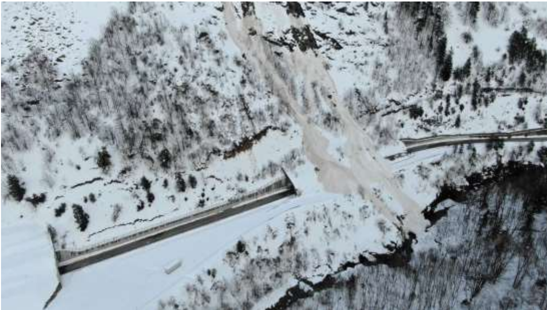
Figura 57 - Opere di difesa passiva sulla SS n° 21 del Colle della Maddalena sommerse dal deposito della valanga (codice 03_L_CN del SIVA - Sistema Informativo VALanghe) che si stacca dai pendii sud-est del Monte Varirosa, fra Vinadio e Sambuco, Valle Stura (CN). Foto effettuata durante i sopralluoghi svolti dalla CLV Valle Stura
