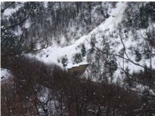
Figura 70 - Sulla sinistra è visibile la zona di accumulo della valanga (codice SIVA: 01_L_CN) che ha interessato la SS del colle della Maddalena protetta dal paravalanghe; sulla destra l'accumulo che è entrato dalle aperture di valle del paravalanghe. Foto effettuata durante i sopralluoghi svolti dalla CLV Valle Stura
