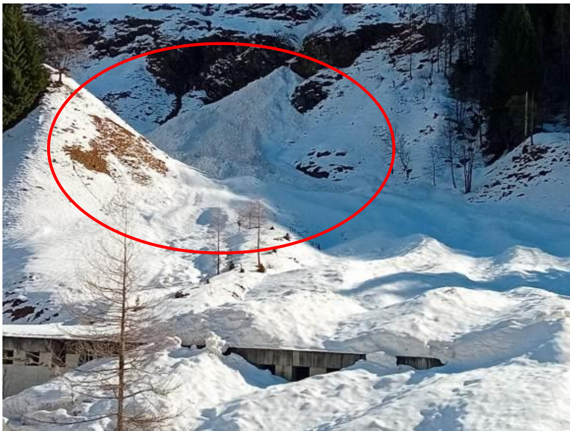
Figura 44 - Deposito della valanga del "Pissone" a monte del tratto della provinciale 224; ancora evidente il deposito che ha interessato la galleria paravalanghe nel fine settimana del 9-10 marzo. Foto della CLV Val Sesia
