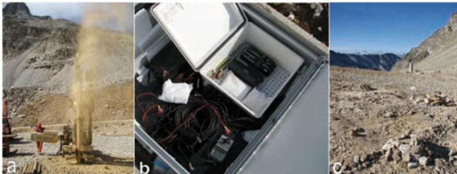
**Figura 4** - Fasi della installazione delle stazioni di monitoraggio del permafrost nelle Alpi piemontesi: a) perforazione, b) installazione strumentazione, c) completamento della stazione (Colle del Sommeiller, Bardonecchia, TO)
