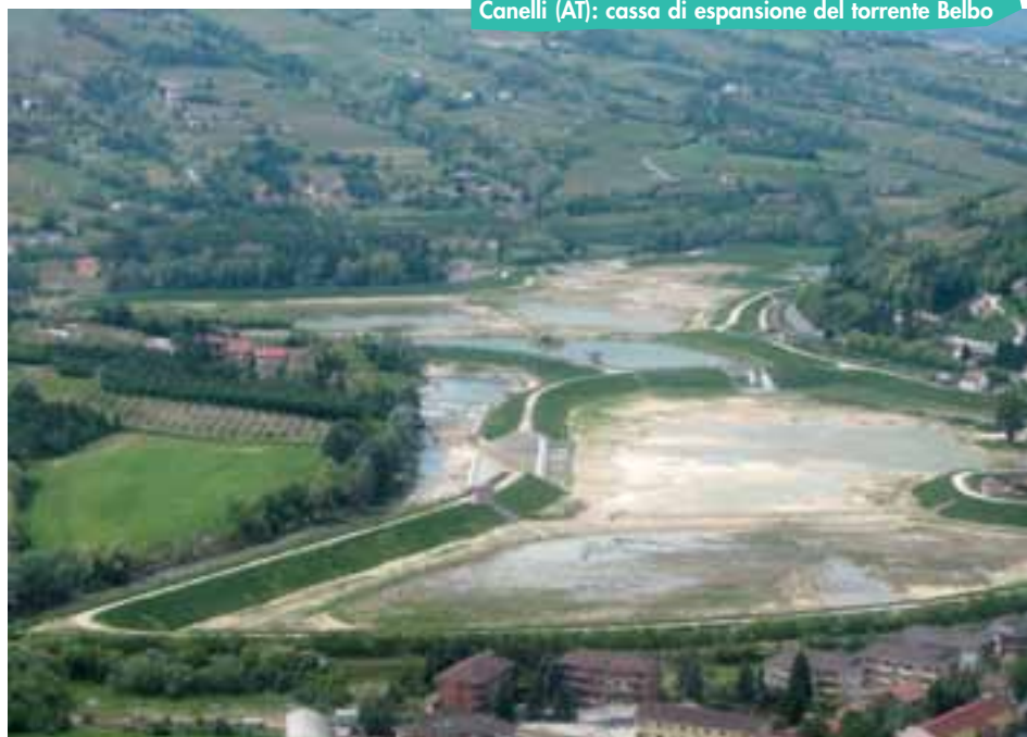
Canelli (AT): cassa di espansione del torrente Belbo
