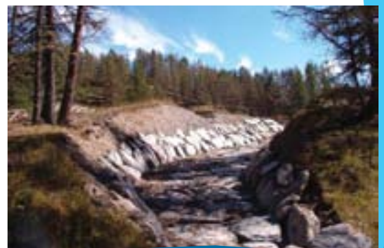
Sistemazione alveo con massi ciclopici
