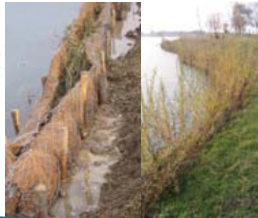
Cava Livorno Ferraris - rullo spondale appena realizzato, lo stesso dopo 8 mesi dopo
