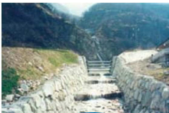
Alveo rivestito e briglia selettiva - canale del Torrente Bertogna, Omegna
