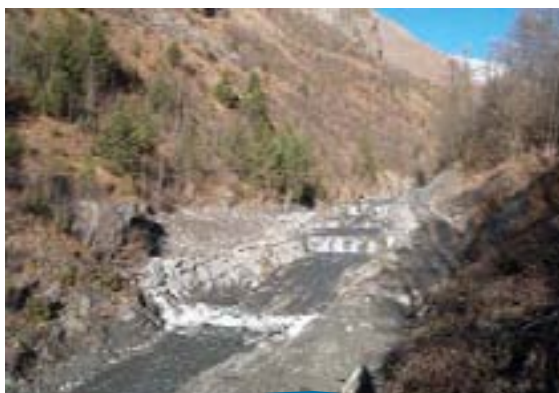
Sistemazione torrente alpino con soglie step-pool
