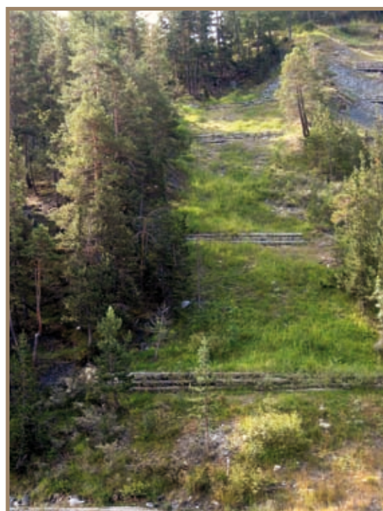
Figura 2.12.14 Impluvi in frana consolidati con palificate di sostegno con funzione di stabilizzazione del detrito di falda contenute trovanti e massi - dopo intervento
