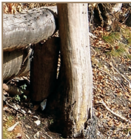
Figure 3.3.100 Gros plan sur la mise hors sol du tronc écorcé
