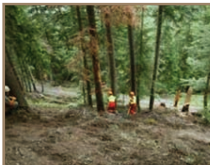
Figure 3.3.86 Réalisation d'une fente d'abattage classique afin que la direction de chute soit orientée perpendiculairement à la ligne de plus grande pente
