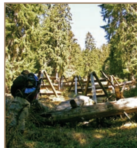
Figure 3.3.113 Dispositif de la figure 3.3.112 mais avec une prise de vue de l'aval vers l'amont. Noter la présence de grumes (ayant un arrêtees un bloc de 1.5 m 3 ) en travers à l'aval des tripodes
