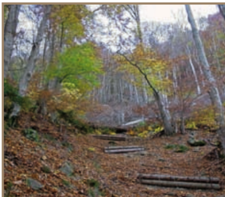
Figure 3.3.109 Exemple de râteliers pare pierres construits avec des grumes ancrées sur des piquets métalliques (Suisse, Martigny). Noter la disposition en arêtes de poisson et la présence de filets pare pierres à l'amont. Le génie biologique est ici utilisé en complément du génie civil pour arrêter les pierres de faibles dimensions qui peuvent passer au travers des mailles du filet
