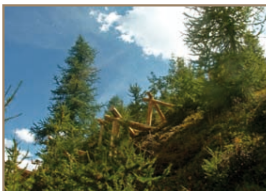
Figura 2.12.5 Cavalletti treppiede per la stabilizzazione del manto nevoso che in caso di zone di caduta massi possono contribuire alla protezione delle piantine forestali utilizzate nei rimboscimenti
