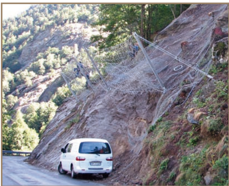
Figura 2.7.63 Interventi di sistemazione realizzati nel mese di luglio 2007. La foto è stata scattata durante la realizzazione degli interventi
