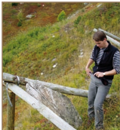
Figure 3.3.117 Exemple de pierre bloquée par un tripodes. (France, Vaujany)
