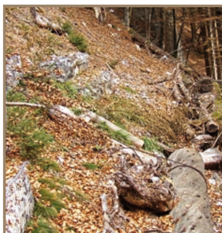
Figure 3.3.103 Exemple d'élingage, à l'aide de câble métallique, de troncs sur des souches (Autriche, vallée du Montafon)
