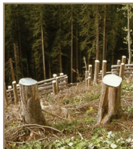
Figure 3.3.107 Exemple de râteliers pare pierres et pare avalanche construits avec les produits d'une coupe (souches et troncs) (K. Kleemayer 2006)
