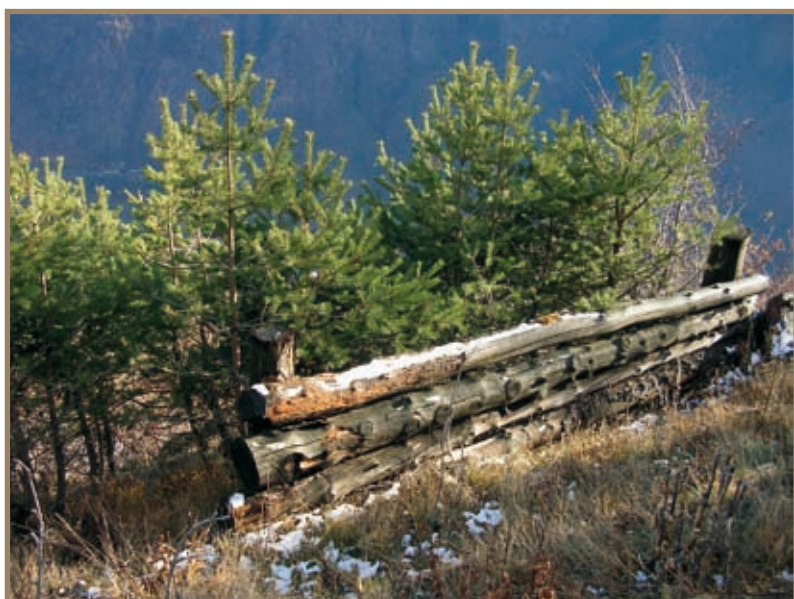
Figura 2.12.4 Palificate semplici a pali sovrapposti in foresta di protezione dalla caduta massi e percorsa da incendio. Le palificate sono state costruite a monte dei nuclei di rimboscimento
