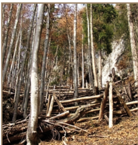
Figure 3.3.111 Exemple de râteliers pare pierres construits avec des grumes et de disposition en andain des rémanents (Autriche, vallée du Montafon)
