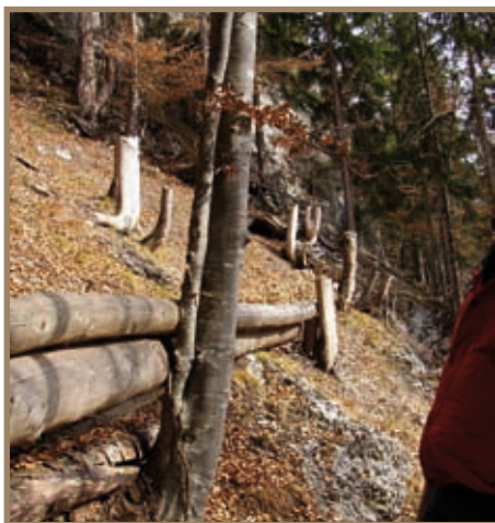
Figure 3.3.99 Exemple d'ancrage de troncs sur des souches écorcées et des arbres vivants (Autriche, vallée du Montafon). Les troncs sont mis en travers car ce secteur est situé au pied de la zone de départ
