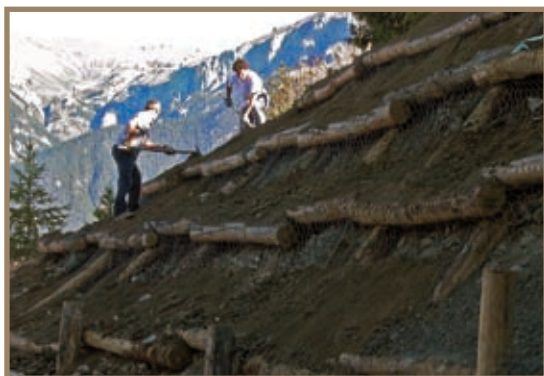
Figura 2.12.17 Grata viva con rete metallica per evitare lo svuotamento dei cassoni in legno (Foto P. Gallo G. Blanchard)
