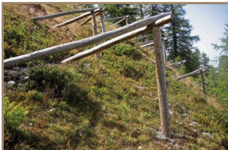
Foto 2.12.30 Realizzazione di cavalletti treppiede in aree di potenziale caduta massi e di scivolamento del manto nevoso
