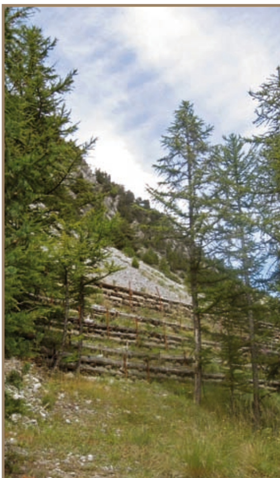
Figura 2.12.37 Vista frontale del rilevato paramassi ed inserimento nel contesto forestale preesistente
