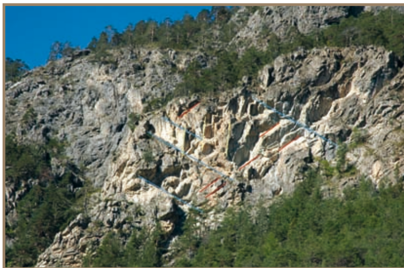
Figura 2.7.45 Esempio di parete in cui sono evidenziati alcuni dei piani di discontinuità rilevati. Al centro della figura è visibile la nicchia del crollo avvenuto nel 2000 nonché i piani di frattura ancora freschi
