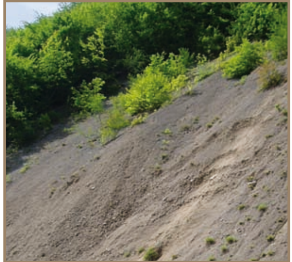
Figure 3.3.67 Vue latérale du site expérimental du Col de Vence (38)
