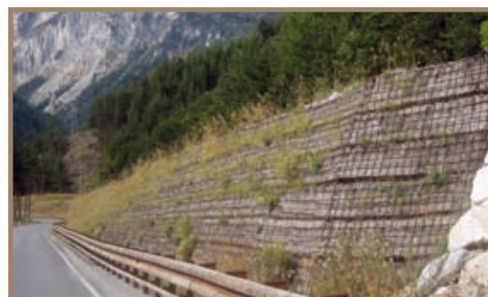
Figura 2.12.18 Vallo paramassi realizzato in terra rinforzata - data l'esposizione ai quadranti meridionali e la notevole capacità di drenaggio dell'opera, nonché l'elevata pendenza del fronte, si osservano notevoli difficoltà di attecchimento della vegetazione sia introdotta artificialmente (idrosemia) che per disseminazione naturale
