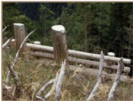
Figure 3.3.108 Exemple de râteliers pare pierres construits avec les produits d'une coupe (souches et troncs) (Autriche, Tyrol). Noter la fixation des grumes sur les souches à l'aide de câbles métalliques et le système à claire-voie basé sur l'utilisation de rondins éviter le contact entre les grumes et faciliter l'écoulement de l'eau. Ceci est d'autant plus important que cet ouvrage est situé dans une zone de fort enneigement. La fonte de la neige et l'écoulement de l'eau de fonte sont facilitées par ce dispositif. (K. Kleemayer 2006)
