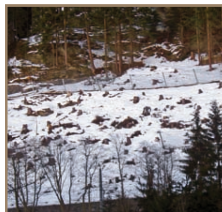
Figure 3.3.106 Exemple d'utilisation de billons et de grumes pour construire des râteliers pare pierres à l'amont de filets pare pierres et qui ont été dimensionnés en conséquence (Autriche, Tyrol). Noter la présence de souches coupées à 1.30 m de haut entre les deux lignes de filets
