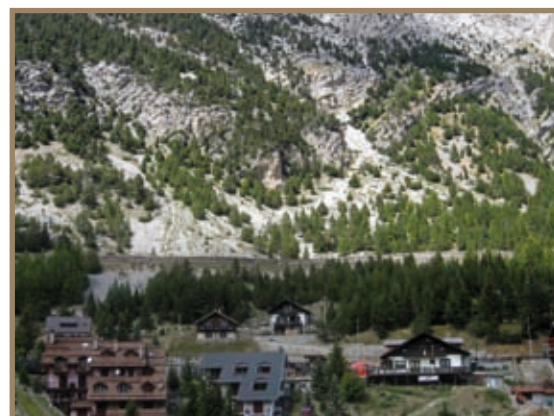
Foto 2.12.39 Centro abitato di Claviere e struttura paramassi a monte delle abitazioni
