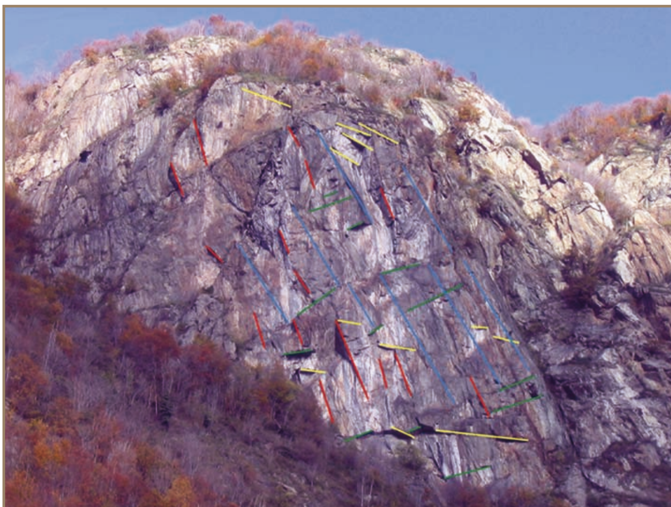
Figura 2.7.5 Esempio di alcuni piani di discontinuità rilevati nell'area omogenea n°1
