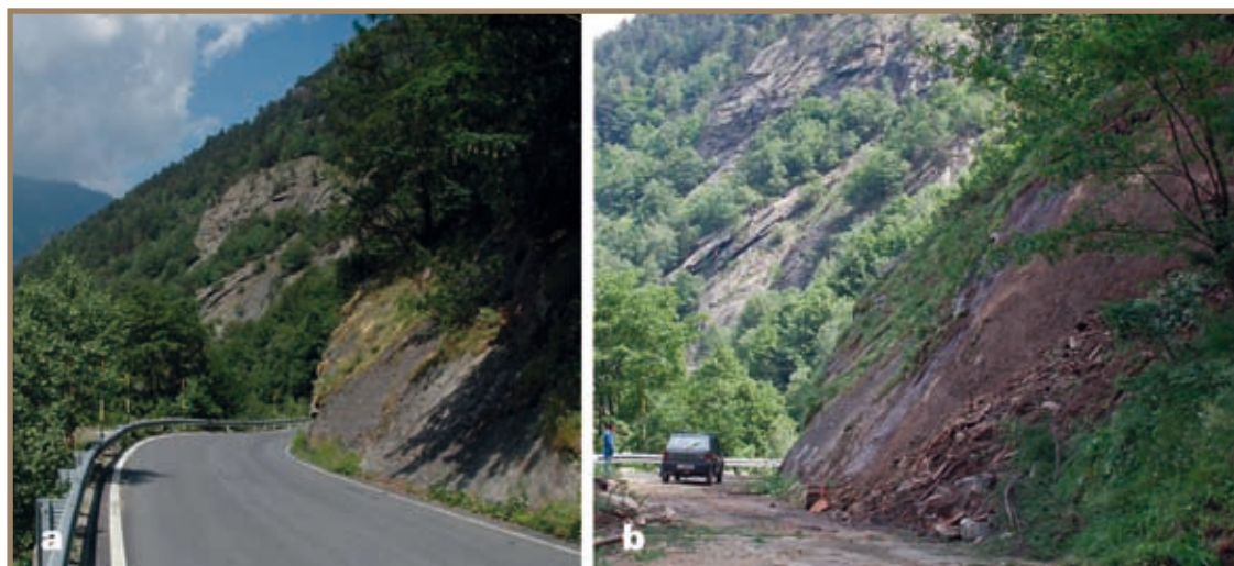
Figura 2.7.64 a) area in cui è avvenuto il crollo, foto scattata nell'estate 2006; b) la stessa zona il giorno immediatamente successivo al crollo
