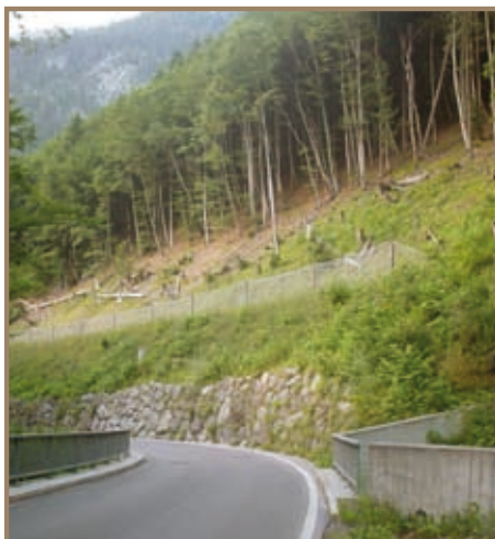
Figure 3.3.118 Exemple d'utilisation conjointe du génie biologique et du génie civil, noter la présence de troncs en oblique et ancrés situés à l'amont des filets pare pierres (Autriche, vallée du Montafon)
