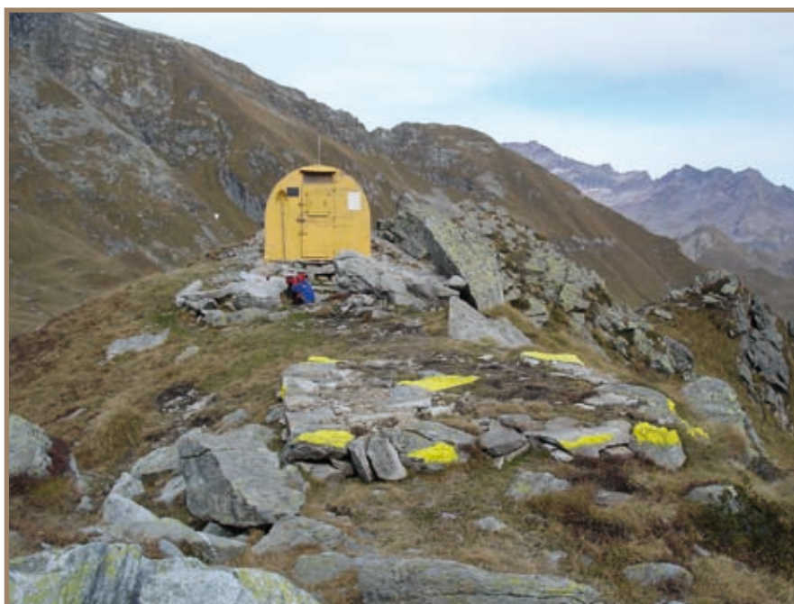
Figura 2.14.2 Bivacco Ravelli; in primo piano la piazzola per l'atterraggio degli elicotteri (F1)
