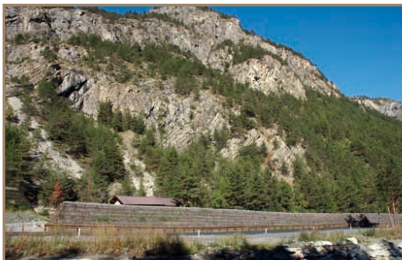
Figura 2.7.46 Parete corrispondente all'area omogenea n° 4, sita in località Melezet
