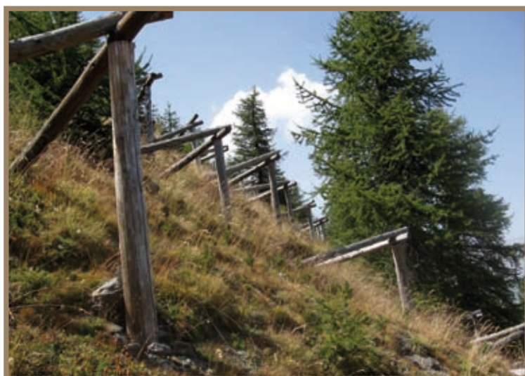
Foto 2.12.30 Realizzazione di cavalletti treppiede in aree di potenziale caduta massi e di scivolamento del manto nevoso
