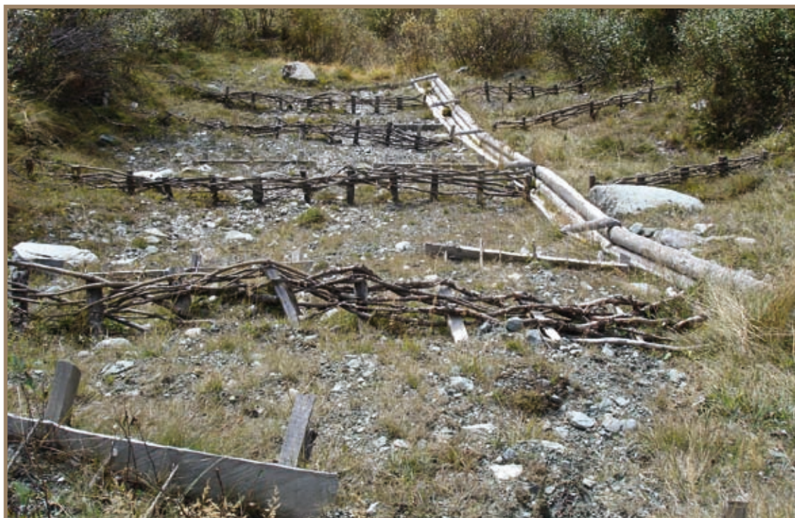
Figura 2.14.3 Pianmisura; sistemazione della colata mediante opere di bioingegneria (F4)
