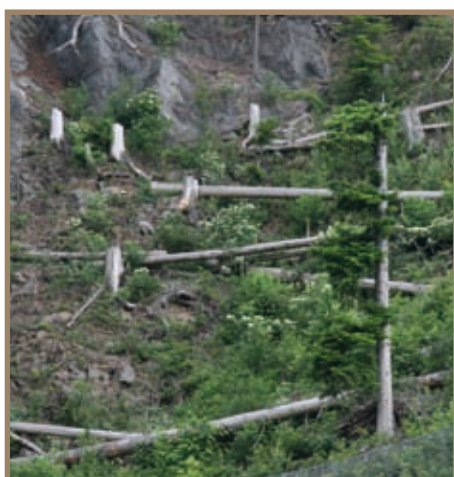
Figure 3.3.102 Exemple de dispositif en arrêtes de poisson avec ancrage de troncs sur des arbres vivants (Autriche, vallée du Montafon)
