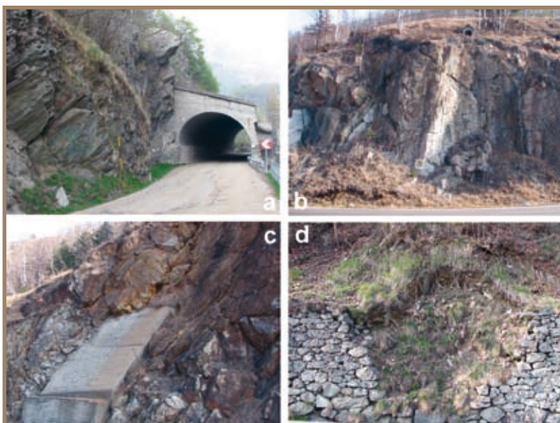
Figura 2.7.35 Esempi di opere di protezione lungo la SP 32: a) galleria paramassi e paravalanghe in località Crot (Usseglio); b) reti zincate in aderenza a bassa resistenza (Germagnano); c) contraforte in cemento armato (Germagnano); d) lesioni ad un muretto a secco (Lemie)
