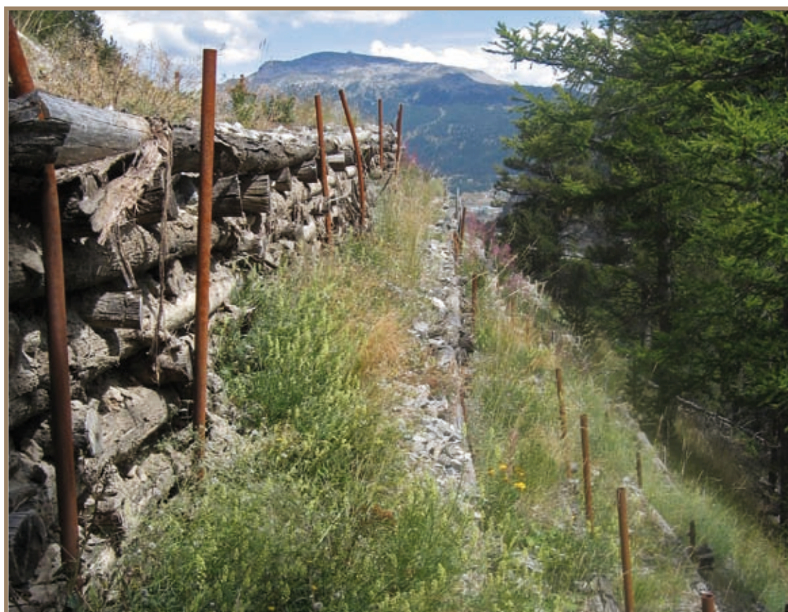
Figura 2.12.35 Fronte di valle del rilevato paramassi
