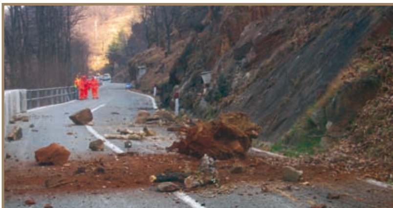
Figura 2.7.27 Lavori di dis-gaggio dei massi instabili effettuati nel febbraio 2007 lungo la SP 32 nel comune di Germagnano (per gentile concessione della Comunità Montana Valli di Lanzo)
