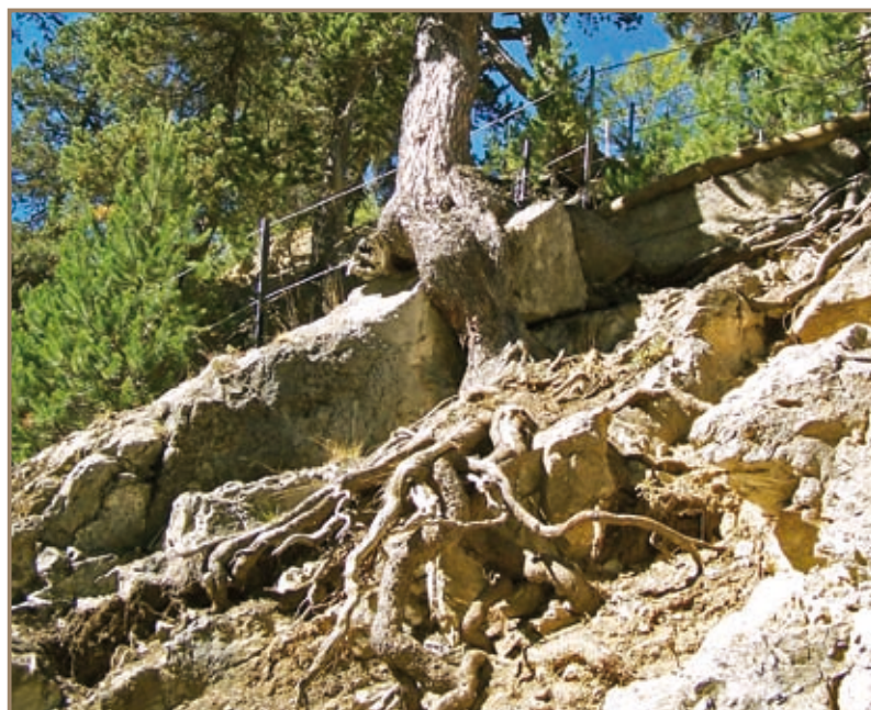
Figura 2.12.3 Apparato radicale - funzione di trattenuta e consolidamento dei massi in area di protezione lungo viabilità pedonale
