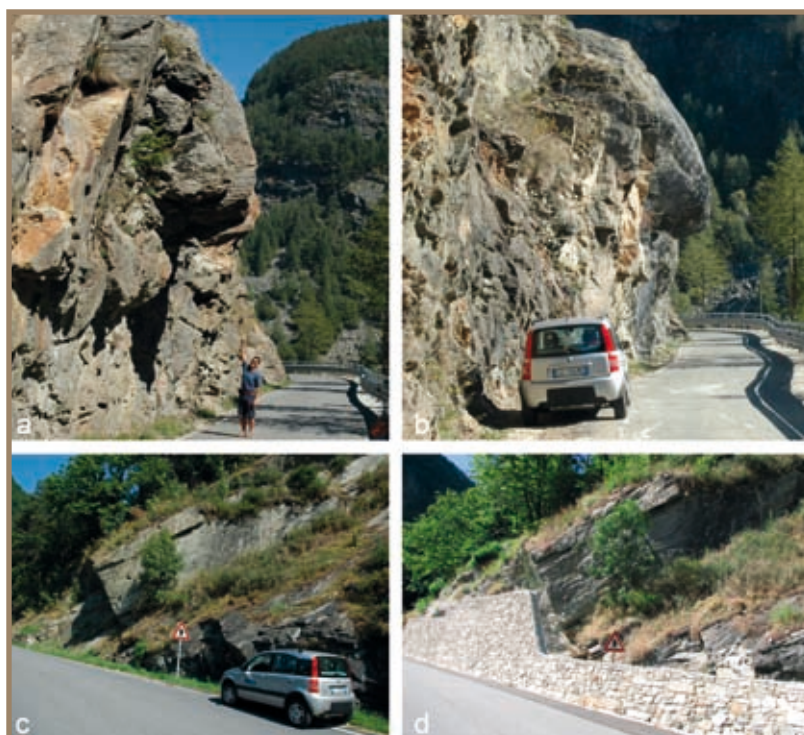
Figura 2.7.57 Alcuni degli interventi di sistemazione realizzati nel periodo successivo al 2006. a) strada per località Rodoretto, foto luglio 2006; b e d) SP 169 dopo l'abitato di Perrero, foto febbraio 2007
