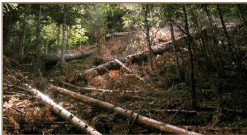
Foto 2.12.24 Interventi selvicolturali di stabilizzazione del popolamento con posizionamento dei tronchi abbattuti a contrastare la caduta massi
