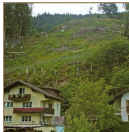
Figure 3.3.119 Autre exemple d'utilisation conjointe du génie biologique et du génie civil, noter la présence de troncs en oblique et ancrés situés à l'amont des filets pare pierres (Autriche, vallée du Montafon)
