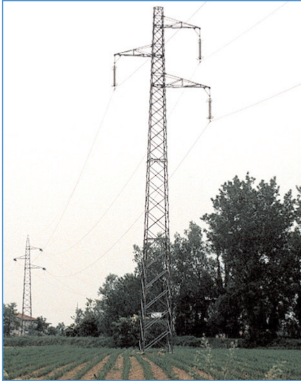
Fig. 7 Esempio di linea a singola terna.
