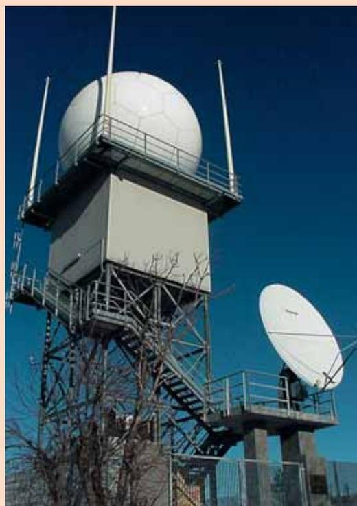
I radar tecnologicamente più avanzati, come quelli in dotazione ad Arpa Piemonte (Figura 1), sono dotati di un particolare sistema di trasmissione dell'impulso elettromagnetico, che permette di variarne periodicamente il
