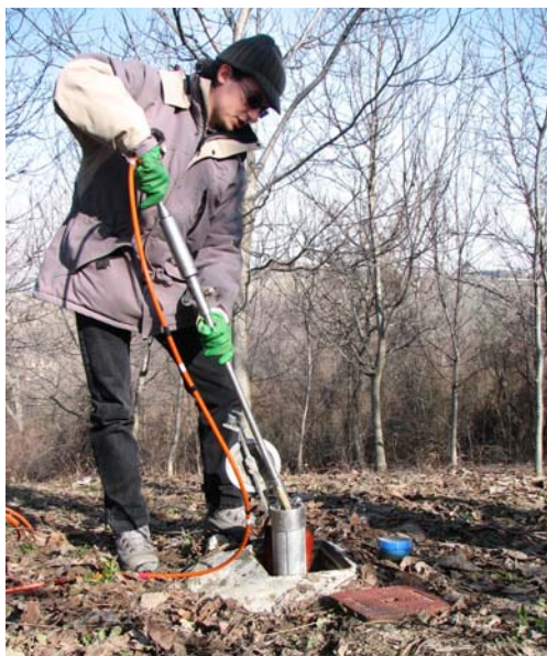
Montelupo Albese (CN) esecuzione misure inclinometriche
