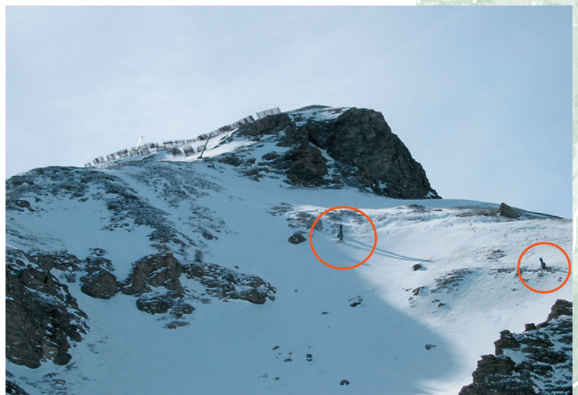
Figura 2.6.10 Opere di difesa attiva da valanghe e esploditori a gas per il distacco programmato delle valanghe (individuati dai cerchi rossi) sul versante NE del Monte Fraitve (comrensorio sciistico della Via Lattea)
