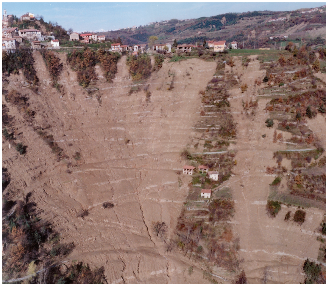
Figura 2.4.2 Evento alluvionale del novembre 1994. Sul versante sottostante Cerreto Langhe alcuni fabbricati vennero sfiorati dalle colate superficiali. Si noti inoltre la coalescenza delle traiettorie delle frane (in Regione Piemonte, 1998)
