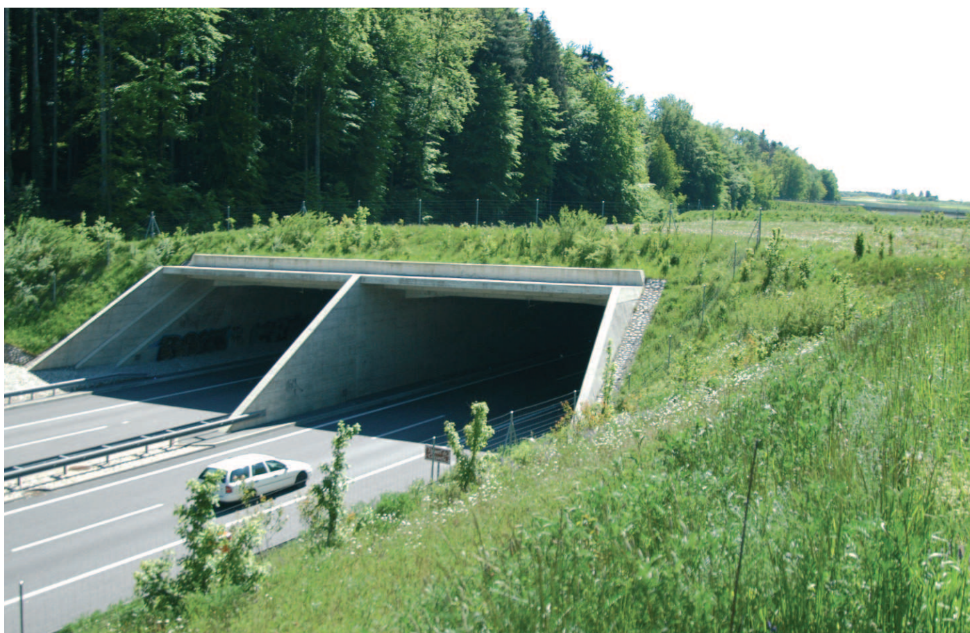
Fig. 17 - Ecodotto di Chévrefu – Particolare copertura dell'ecodotto
