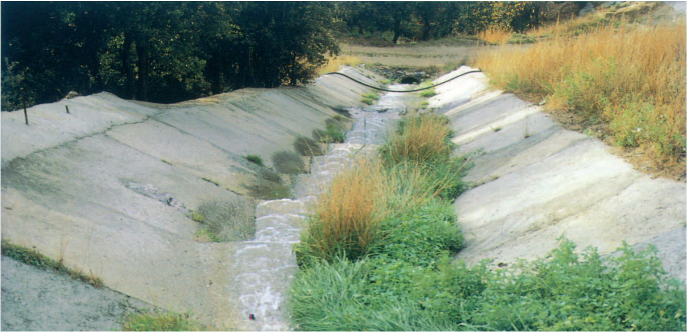
Fig. 18 - Rampe di accesso alle scarpate su scalinata idraulica per favorire il passaggio della fauna (tratto da Rosell, 1999)
