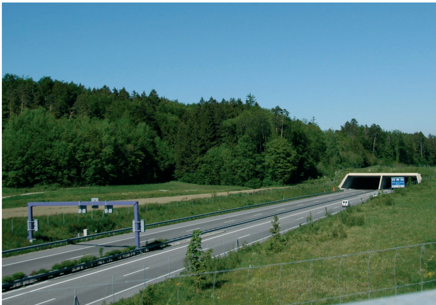
Fig. 16 - Ecodotto di Chévrefu – Autostrada N1 Yverdon-Avenches (Neuchatel - Svizzera). Vista dell'ecodotto all'intersezione dell'autostrada con un corridoio ecologico di importanza nazionale
