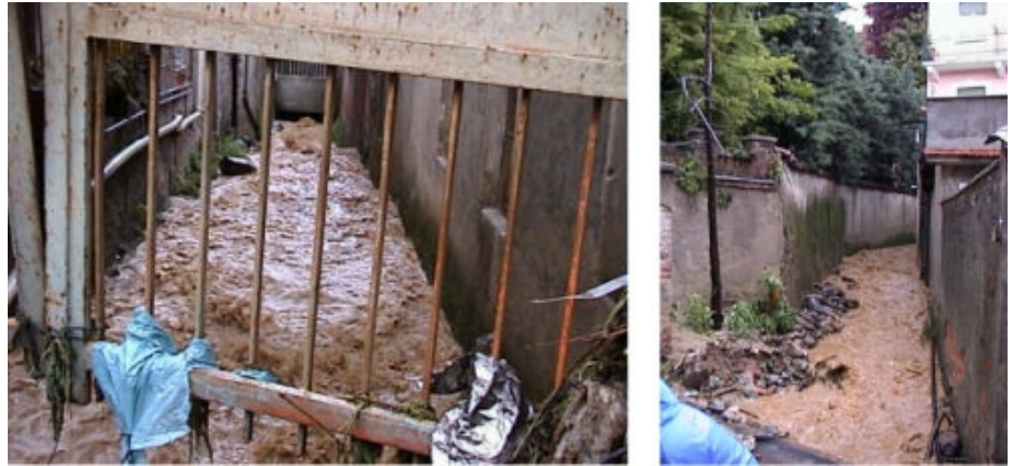
Figura 27: Canalizzazione del rio Sacchetto all'interno dell'abitato di Chiavazza
