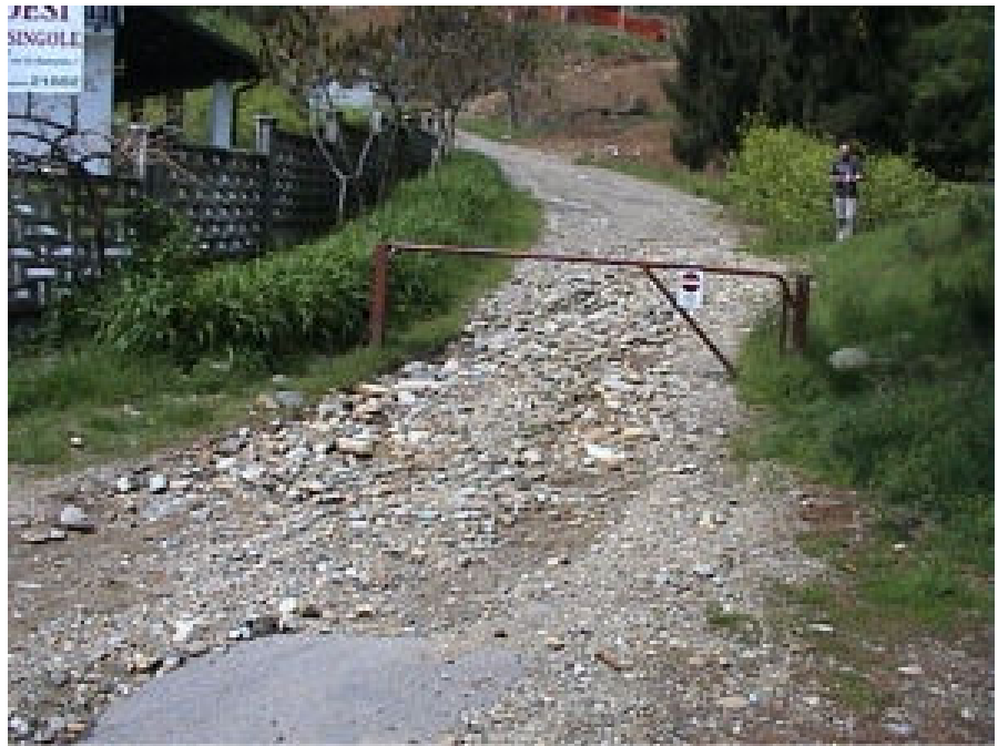
Figura 21: Mulattiera da cui sono partite le acque incanalatesi in via Matteotti.
