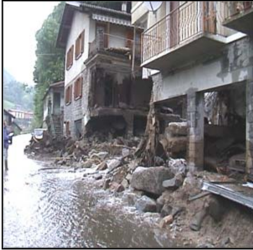
Fig.22. Comune Quittengo, loc. Malpensà: le due case, situate sulle sponde del rio Quittengo, che sono state semidistrutte.
