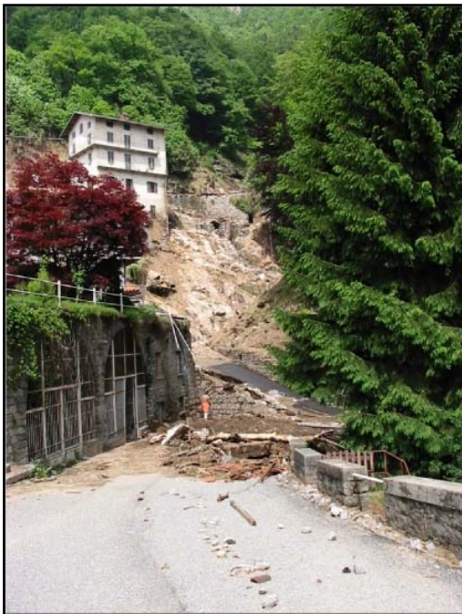
Fig.23. Comune di Quittengo, loc. concentrico: la colata detritica lungo il rio Collino che ha lesionato la casa visibile nella foto e una seconda situata più a valle, asportato parte della strada e alcuni muri di contenimento.
