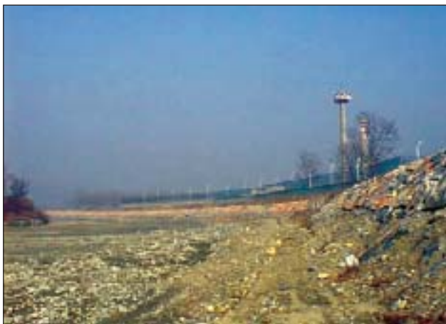
Figura 1- Condizioni dell'argine fluviale lungo il perimetro del Comprensorio nucleare di Saluggia in data 16 febbraio 2004.
