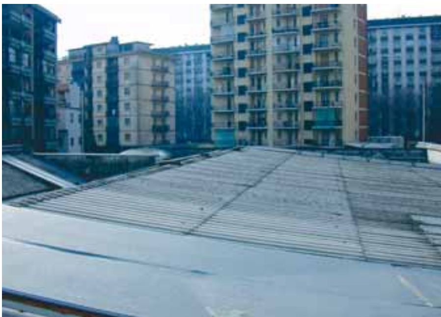
Tettoia in buono stato di conservazione
