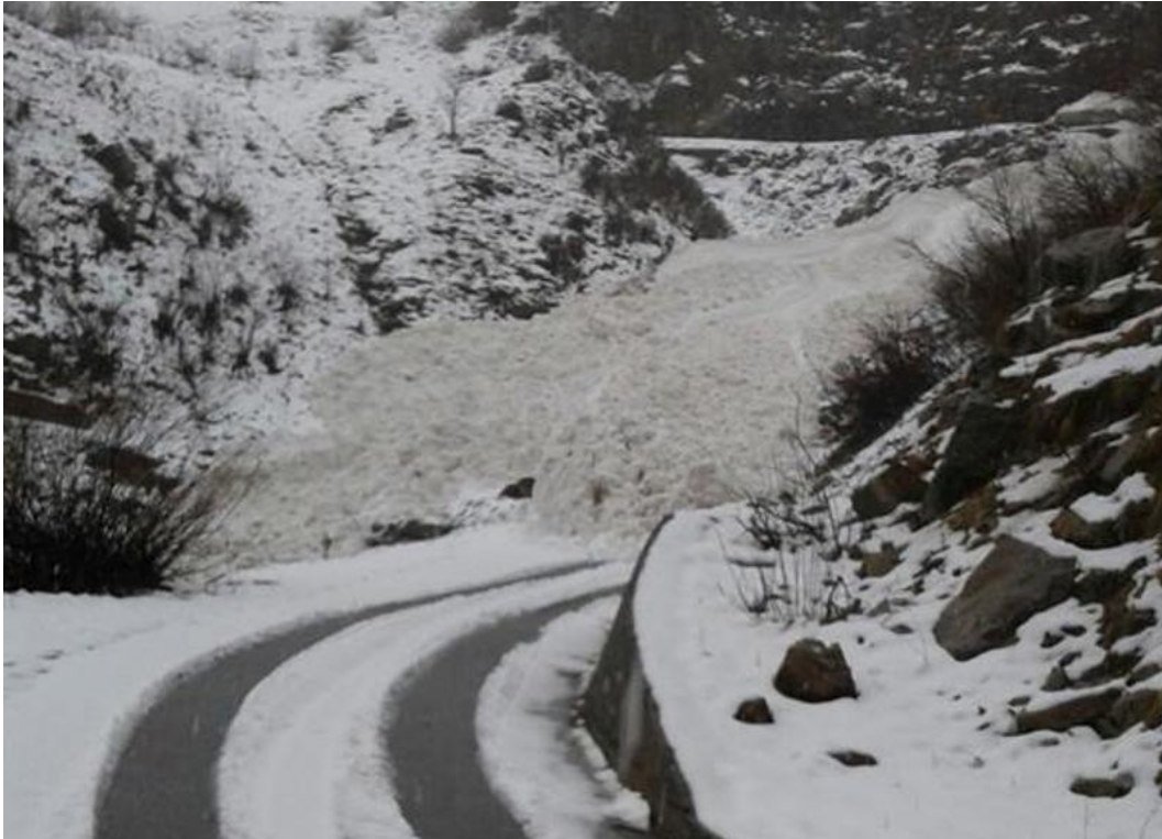
Figura 4. Accumulo della valanga sulla strada comunale di Entracque (CN)
