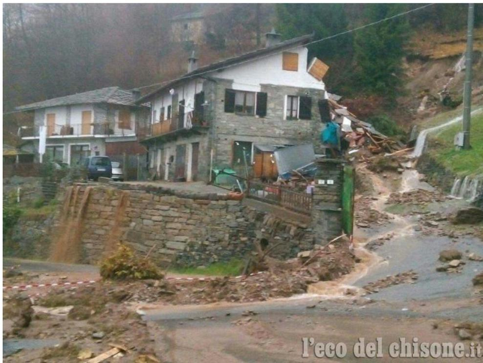
Figura 18. Frana rotazionale interessante la coltre di copertura poggiate sul substrato cristallino in territorio comunale di Rorà ha travolto un'abitazione (Foto Eco del Chisone)
