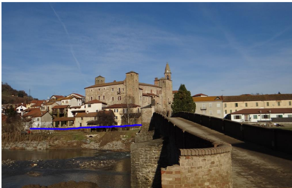
Figura 6. In primo piano il ponte di Monastero Bormida. La linea blu indica il battente d'acqua raggiunto sugli edifici a monte dell'opera nell'evento 2016. L'attraversamento è rimasto intatto
