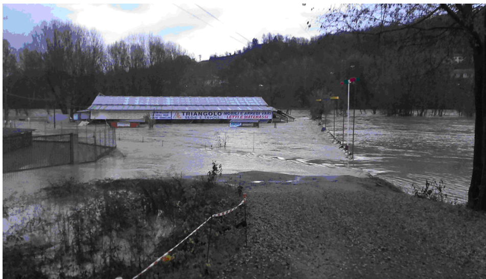
Figura 12. Acqui Terme, 25/11/2016, ore 7.30 circa, sponda sinistra del fiume Bormida, località Sotto Argine, edifici compresi tra la SP30 e il fiume
