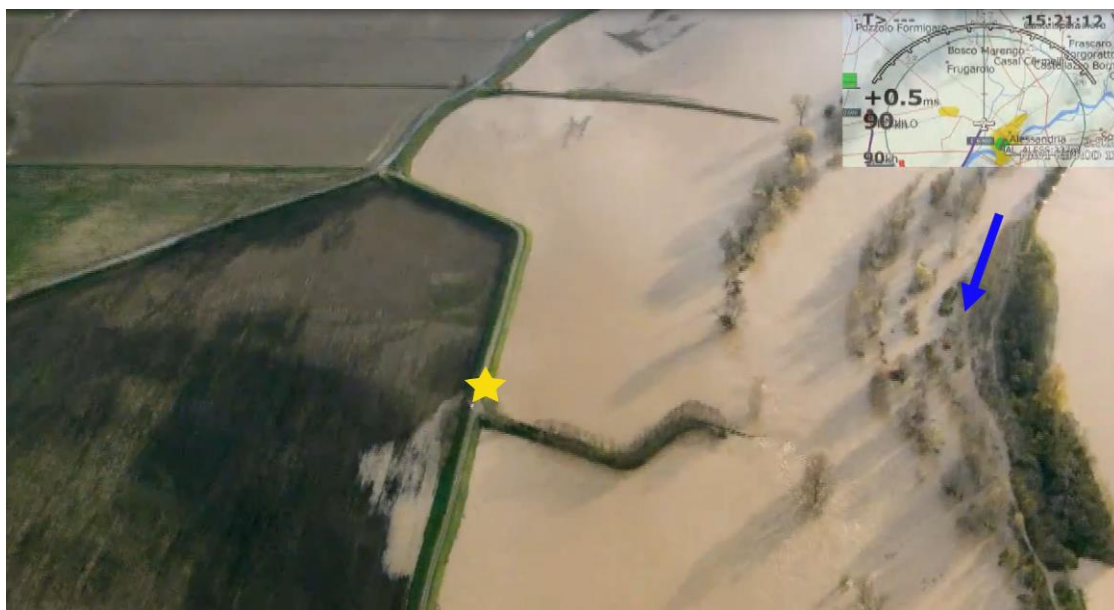
Figura 19. Effetti della piena del fiume Bormida a Castellnuovo Bormida (Foto a sinistra - Goldini M.). Edificio di servizio della centrale idroelettrica ad acqua fluente posta in corrispondenza della traversa a monte del ponte tra Cassine e Castellnuovo. (coordinate edificio: lat. 44°45'1.53"N, long. 8°32'37.32"E). La foto è stata scattata alle ore 11:28 del 25/11/16
