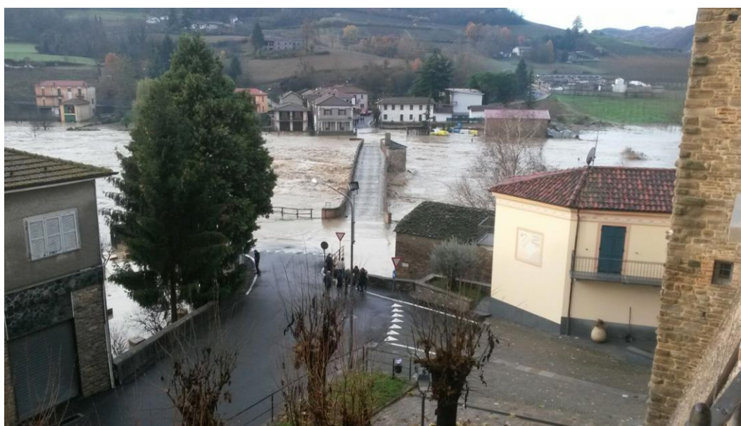
Figura 5. Ponte romano di Monastero Bormida durante la piena del 25 novembre 2016
