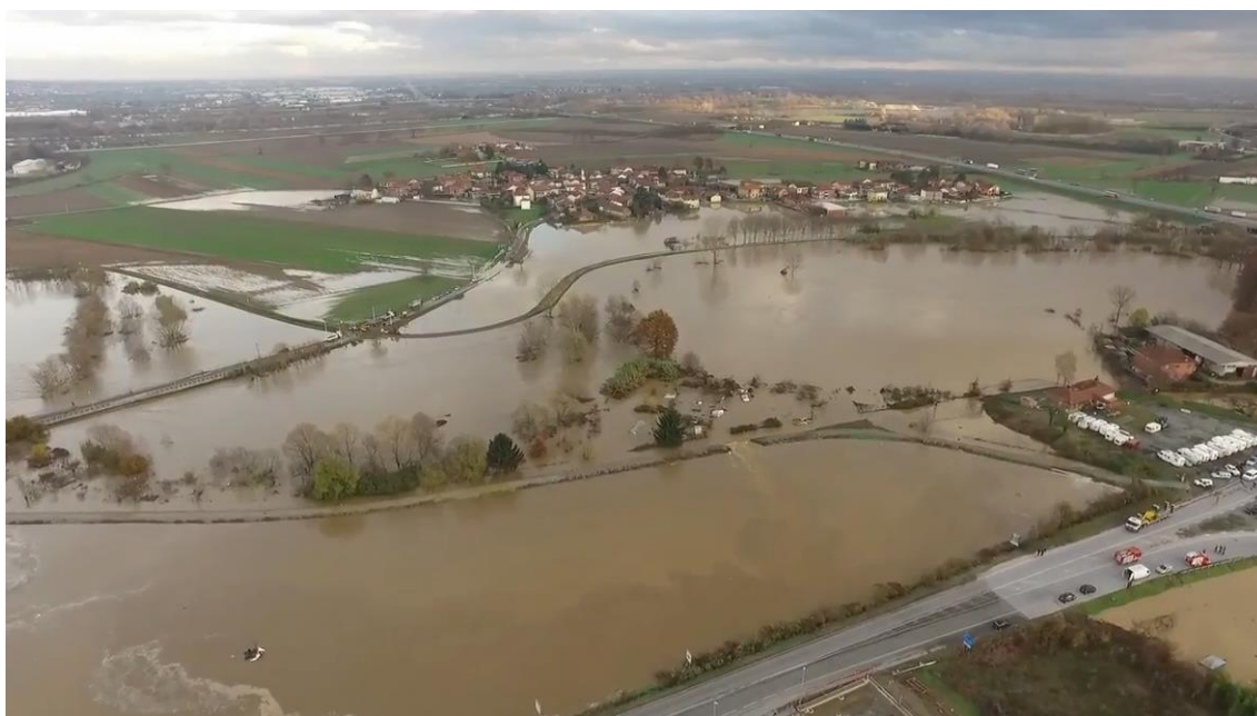
Figura 10. Comune di Moncalieri; rotta arginale a sud di Strada Barauda. (www.youtube.com, Giorgio Ferraris)
