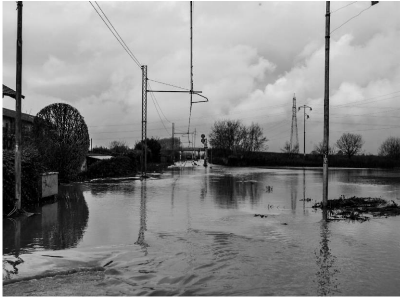
Figura 7. Sponda sinistra sopraelevata della SP142 per Piobesi che ha consentito il deflusso delle acque verso il concentrico di Candiolo (foto sig.ra Miriam Sintajova)
