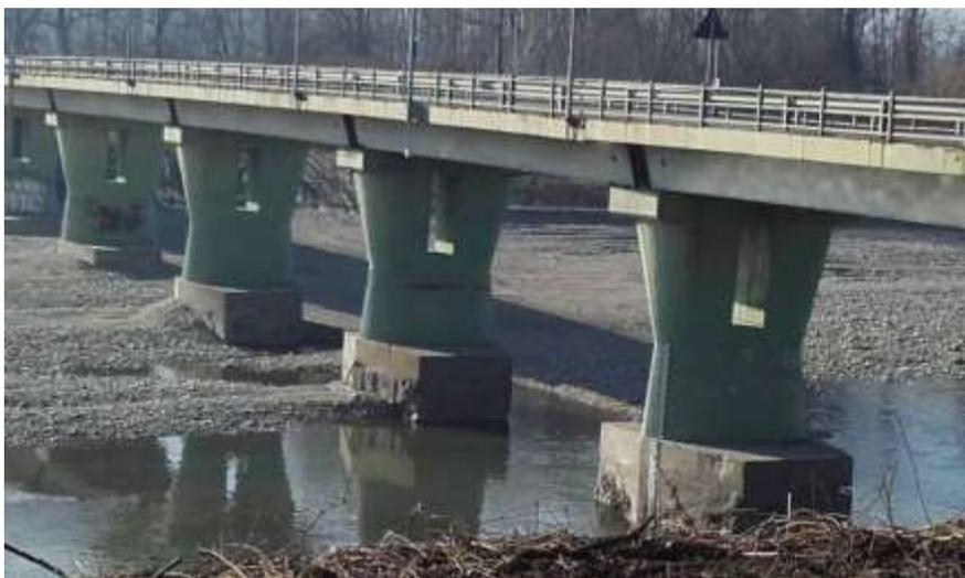
Figura 22. Il Ponte della SP 92 ha subito danni strutturali ad una pila e pertanto è stato chiuso al traffico
