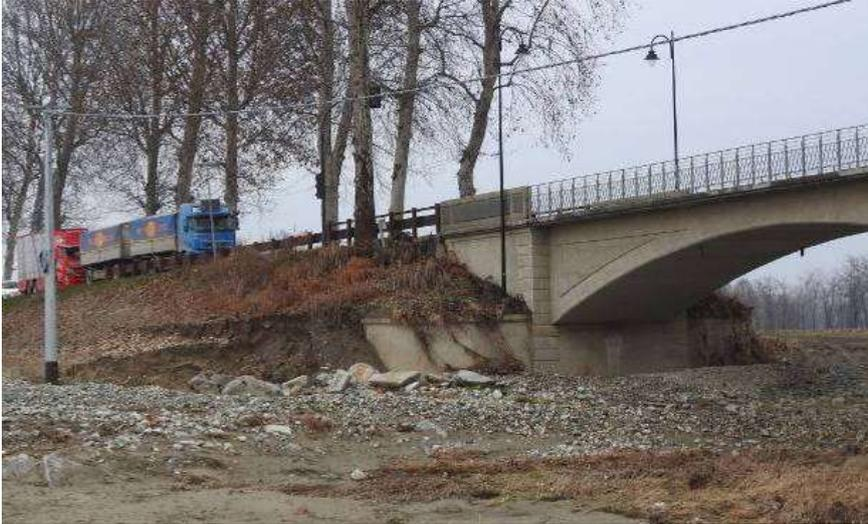
Figura 2. erosione rilevato sponda sinistra a Cardè
