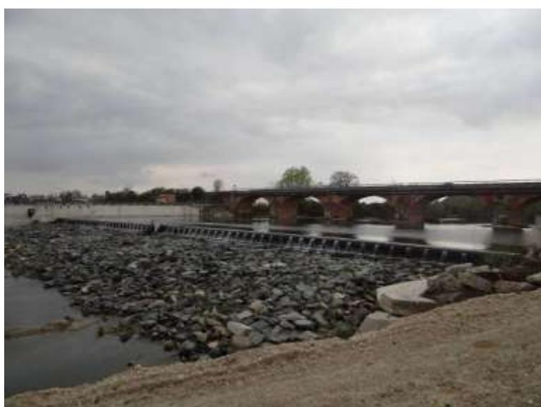
Figura 6. In primo piano la traversa a servizio dell'opera di presa e il ponte della strada SP663
