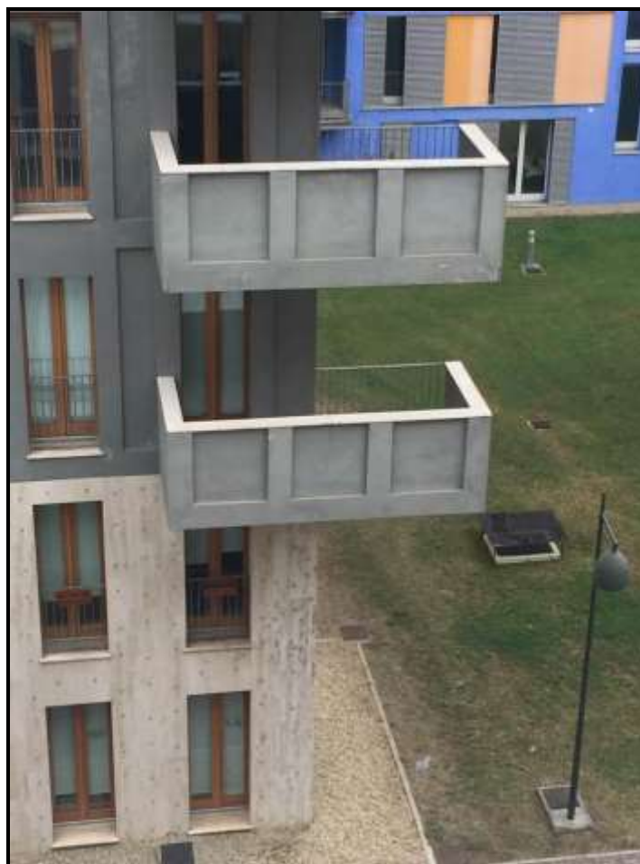
Figura 5: Palazzina B2 – in evidenza il doppio sbalzo del balcone
