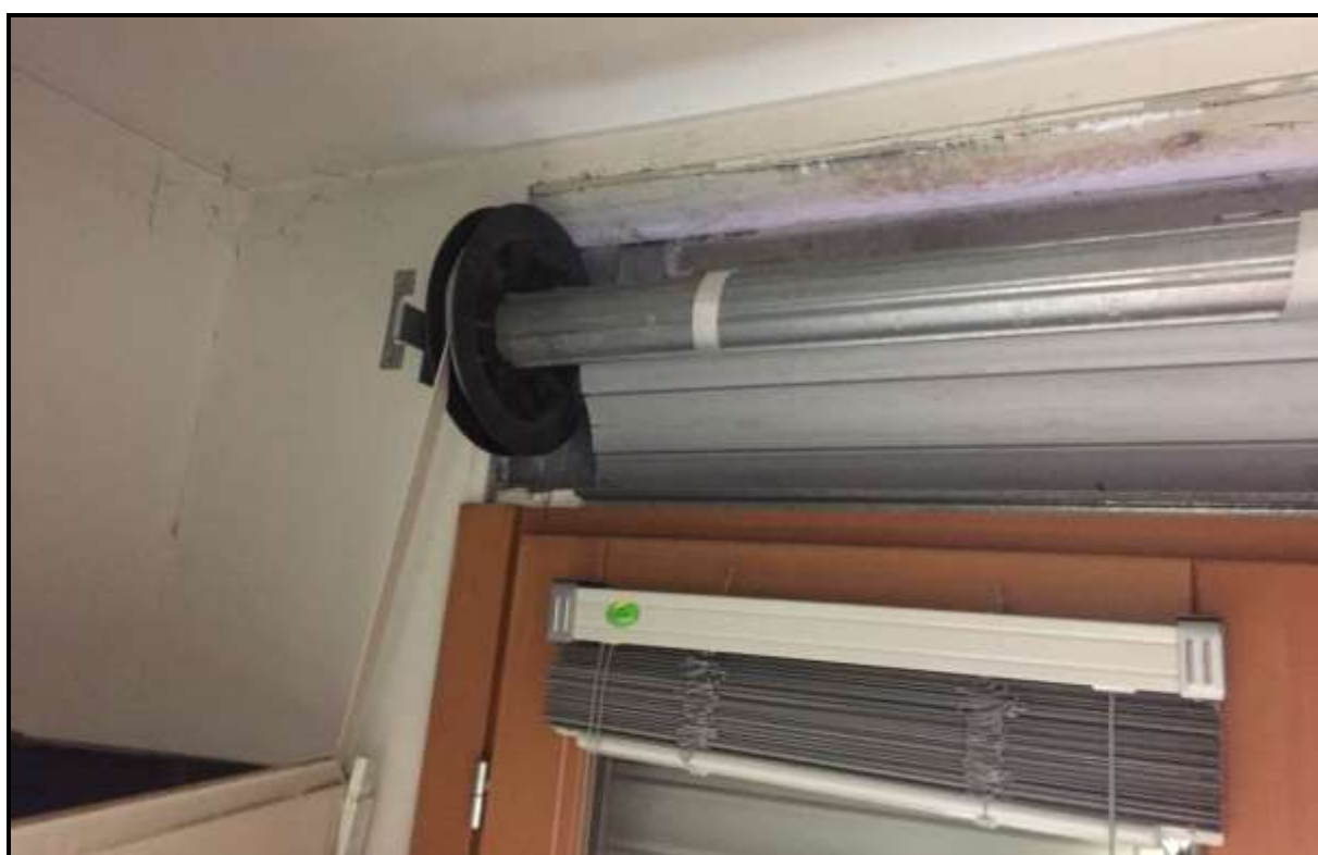
Figura 15: Palazzina D0 – cassonetto dell'avvolgibile aperto
