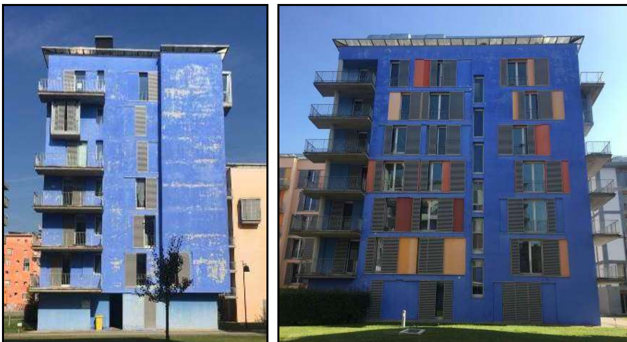
Figura 10: Palazzina C1 – vista lato sud (sx) e lato ovest (dx)
