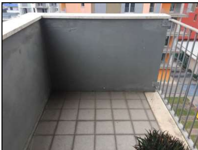
Figura 4: Palazzina B2 – in evidenza il parapetto del balcone realizzato in muratura ed in metallo
