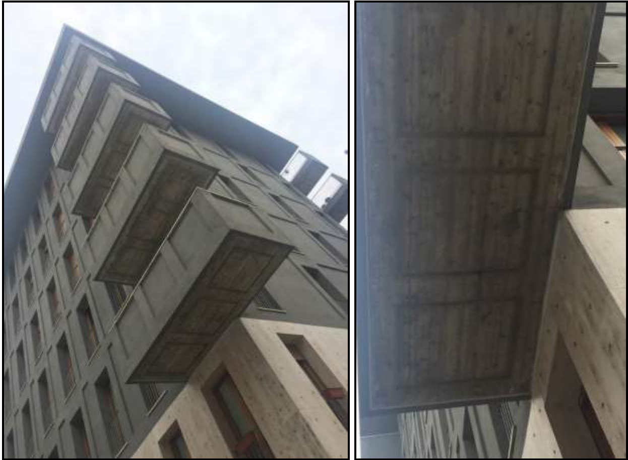
Figura 8: Palazzina B2 – in evidenza gli intradossi dei balconi
