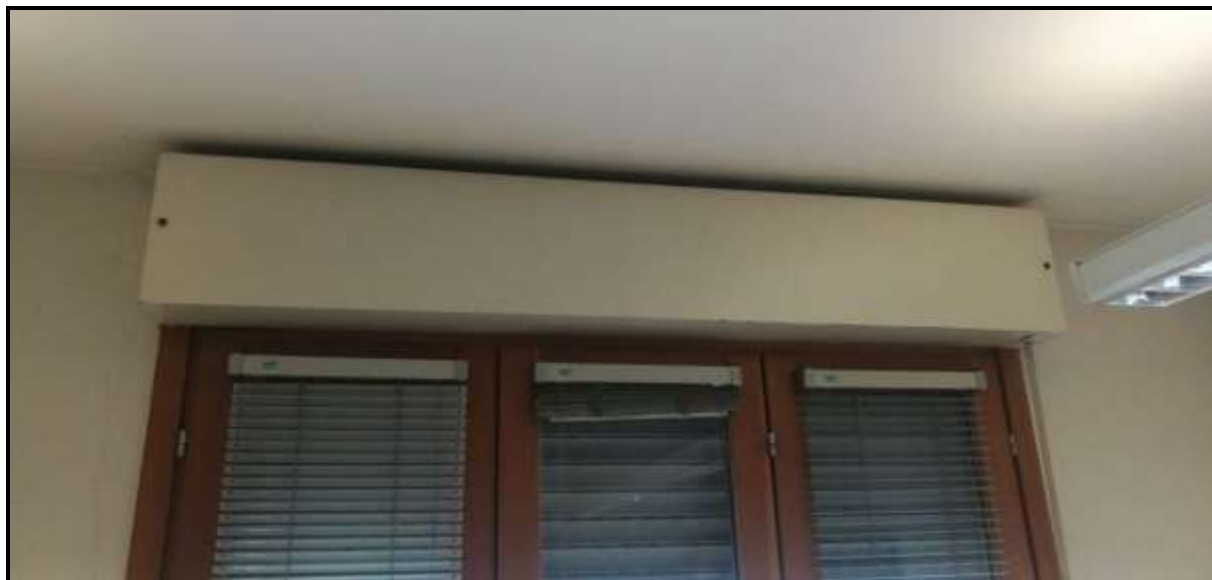
Figura 14: Palazzina D0 – cassonetto dell'avvolgibile
