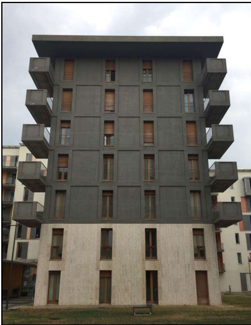
Figura 3: Palazzina B2 – vista lato sud
