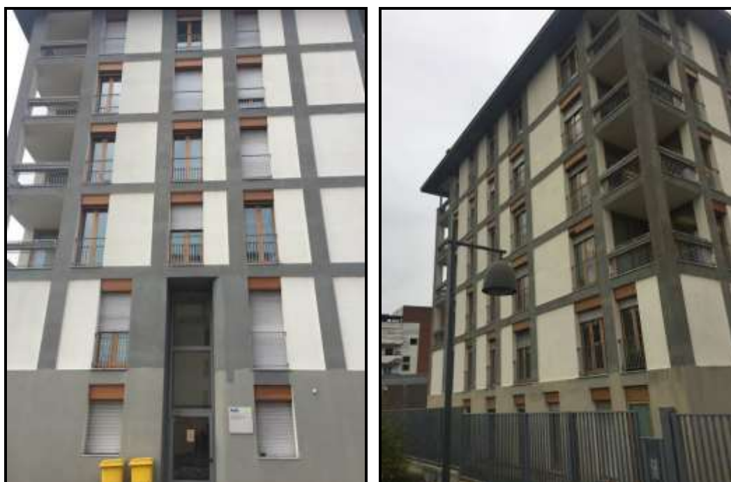
Figura 19: Palazzina D0– vista lato nord (sx) e lato est (dx)
