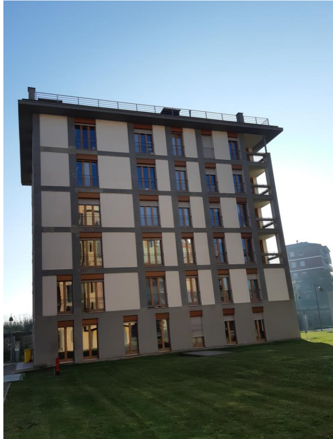
Figura 3. Stato di fatto della palazzina D0 i cui lavori si svolgeranno internamente al fabbricato
