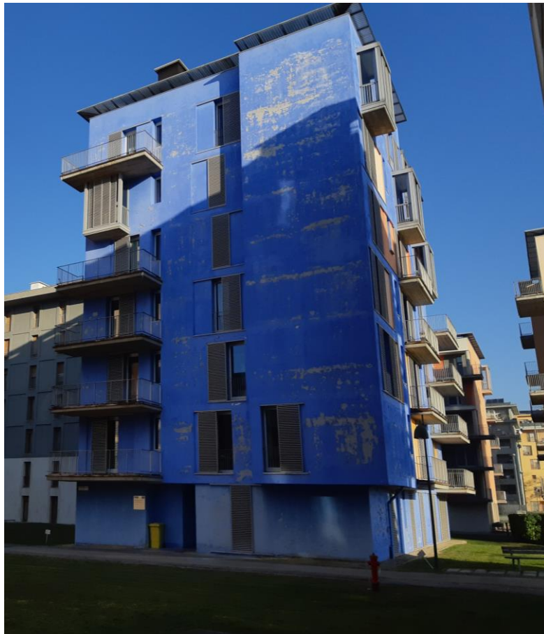
Figura 2. Stato di fatto della palazzina C1 i cui lavori interesseranno la manutenzione delle partizioni verticali esterne
