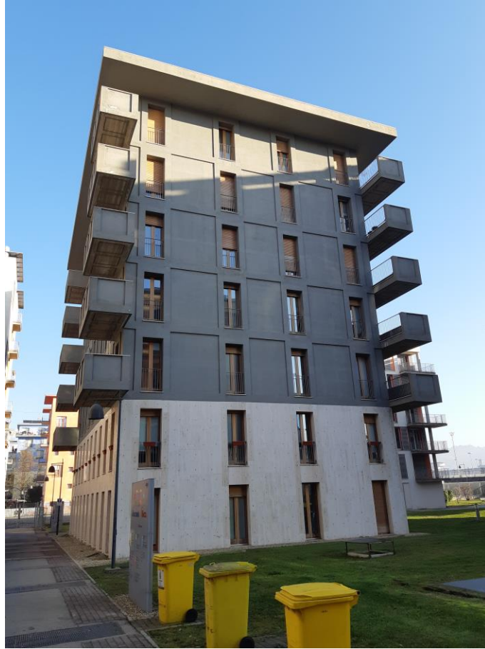
Figura 1. Stato di fatto della palazzina B2 i cui lavori riguarderanno la manutenzione degli elementi strutturali e le pareti esterne
