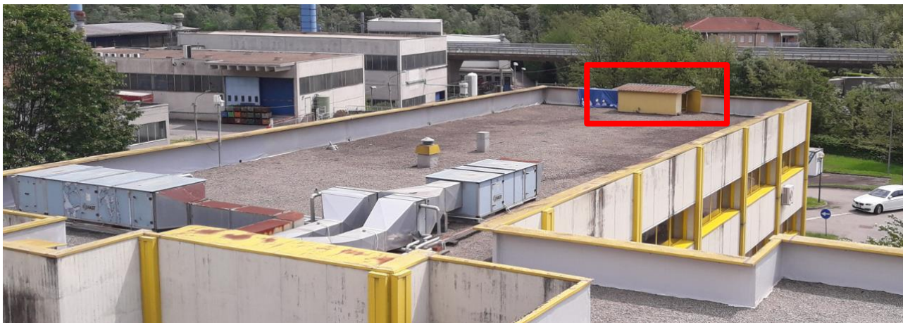
Fotografia 3 - manufatto di protezione da eliminare
