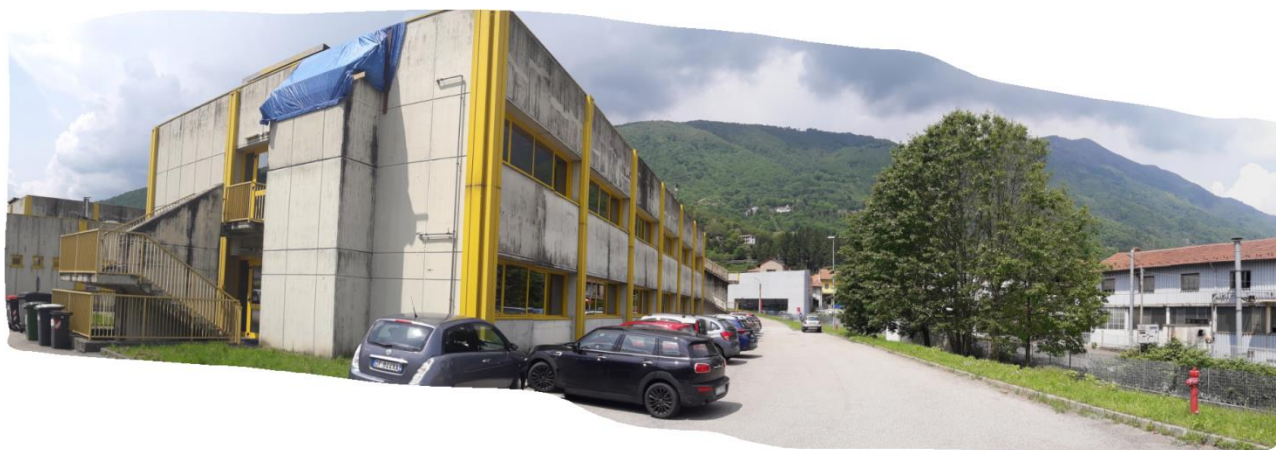
Fotografia 1 - area di cantiere
