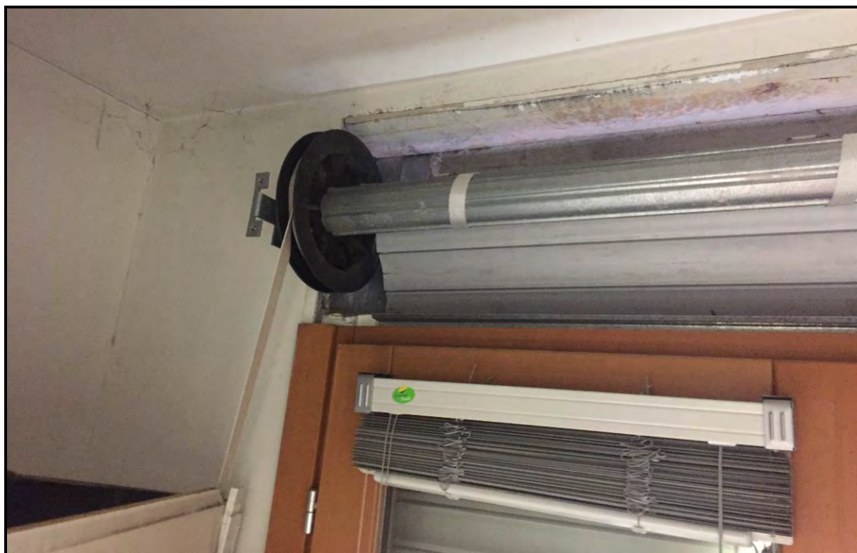
Figura 15: Palazzina D0 – cassonetto dell'avvolgibile aperto
