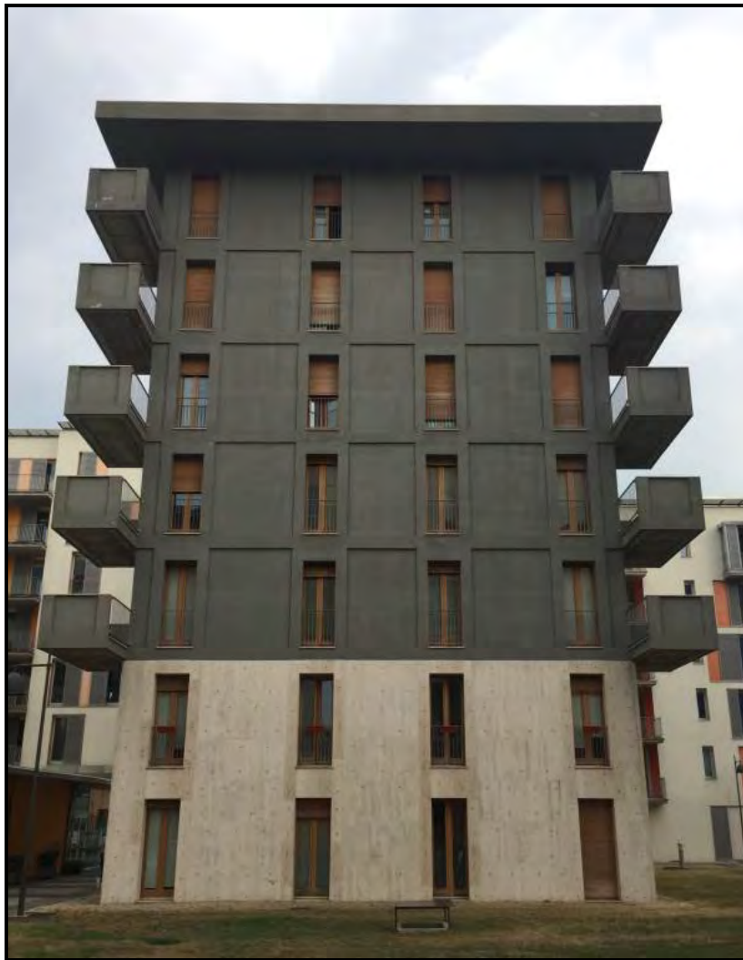
Figura 3: Palazzina B2 – vista lato sud
