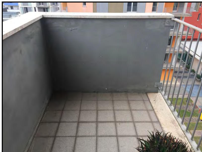
Figura 4: Palazzina B2 – in evidenza il parapetto del balcone realizzato in muratura ed in metallo
