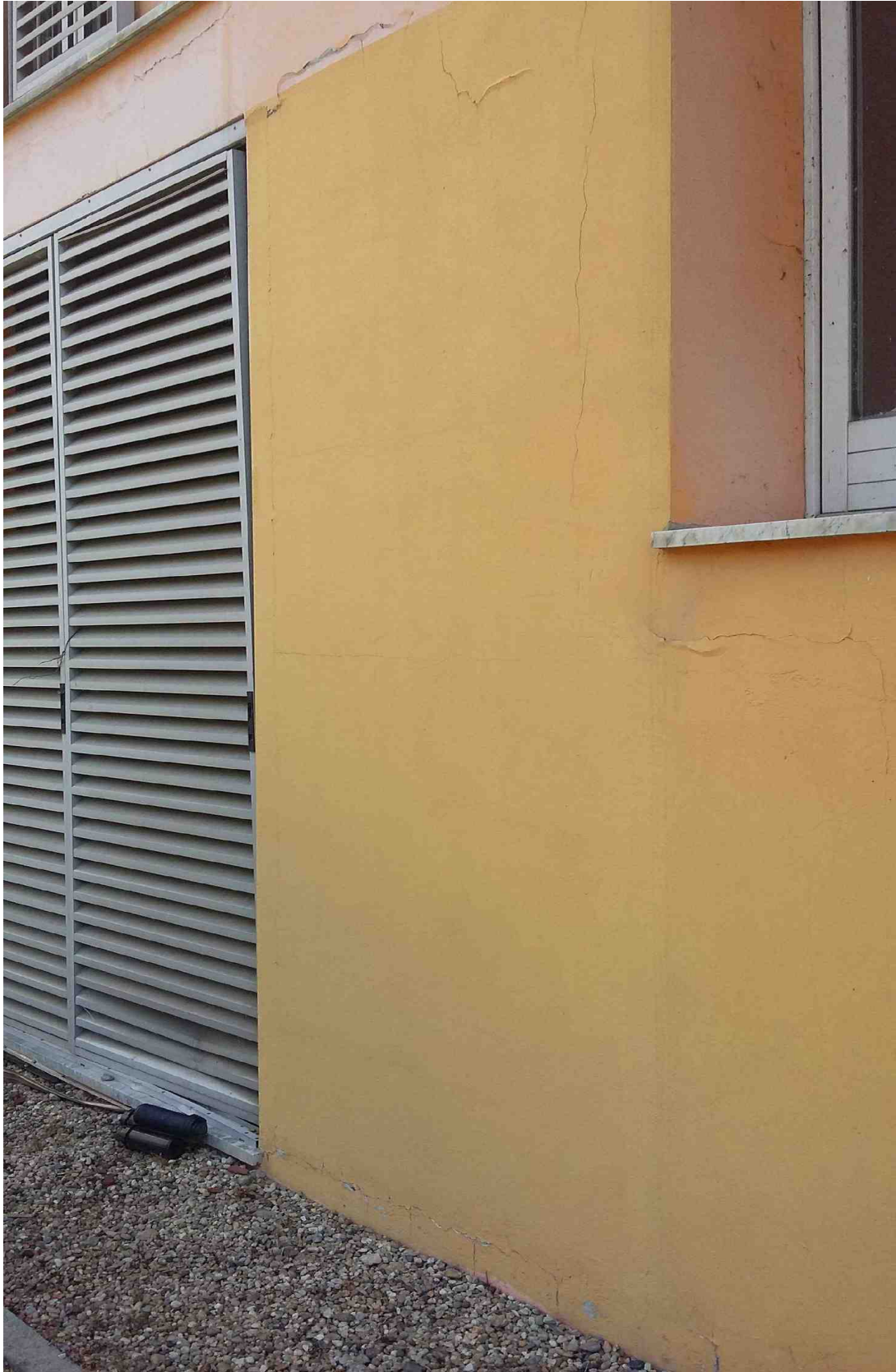
PIANO TERRA, VANO SCALA
