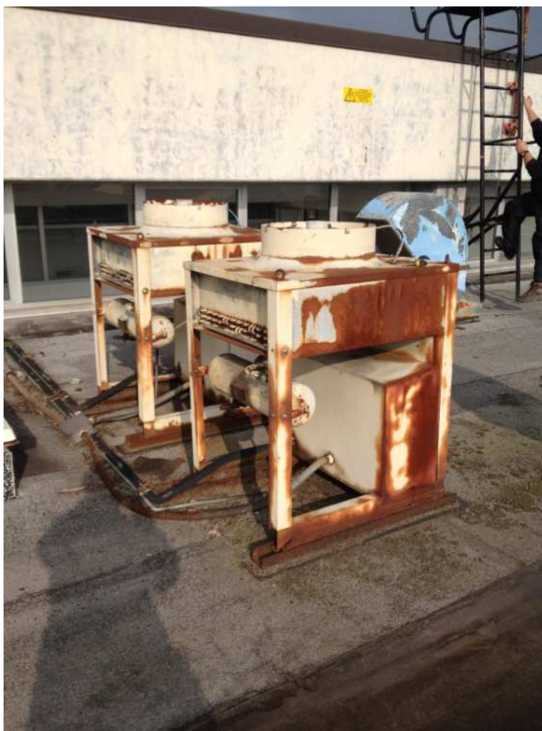
Impianti dismessi rimuovere
