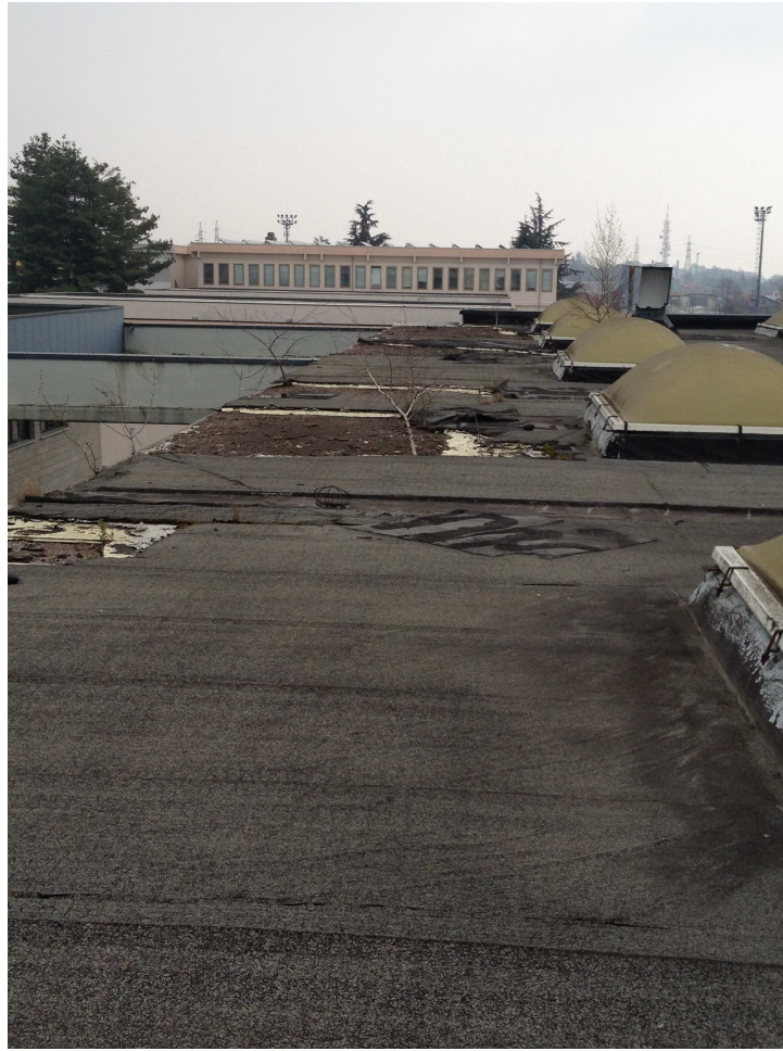
Parte del tetto da demolire e rifare
