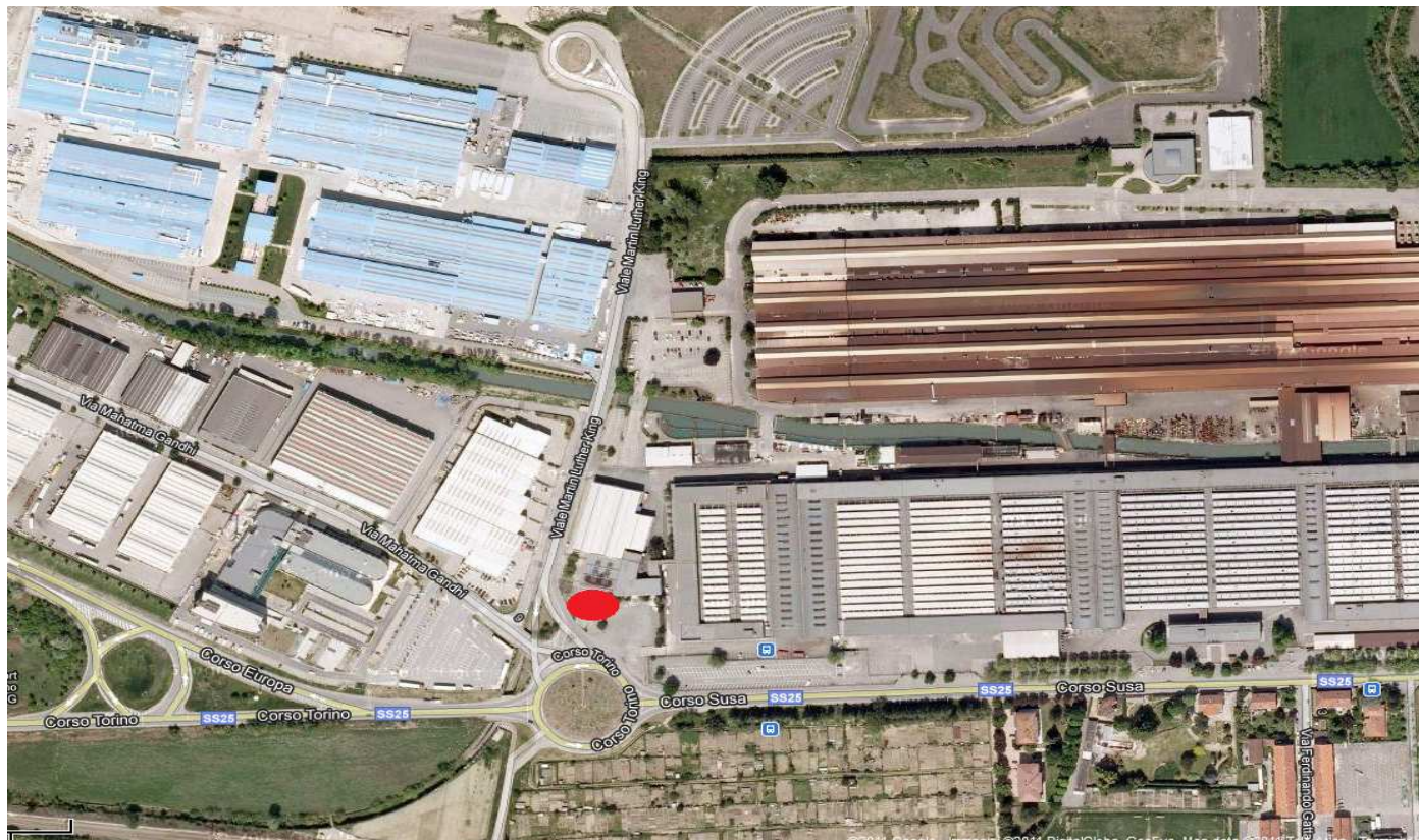
Figura 2 - Ubicazione del Laboratorio Mobile per il monitoraggio della qualità dell'aria nel comune di Avigliana.
