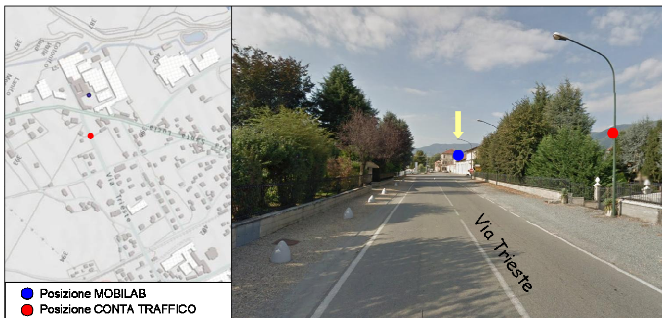
Figura 32 - Sito di monitoraggio del traffico.
