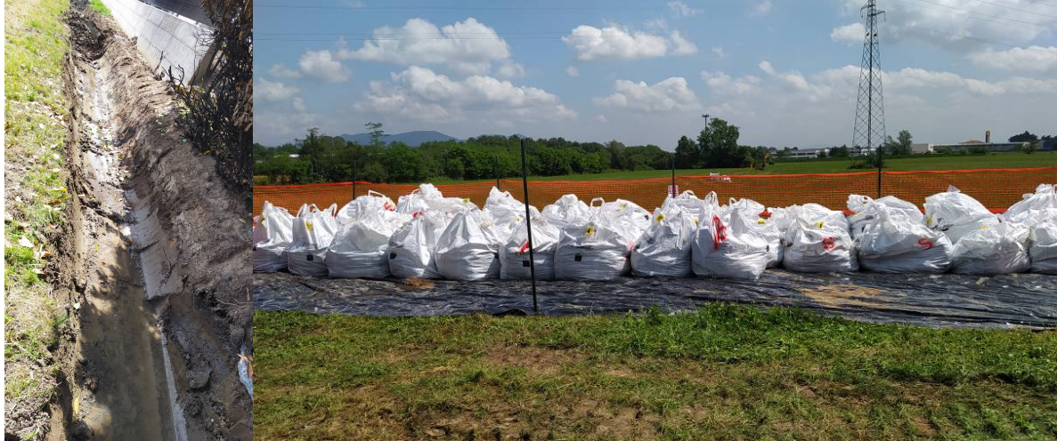
Foto 3. Asportazione del materiale contaminato dai canali
