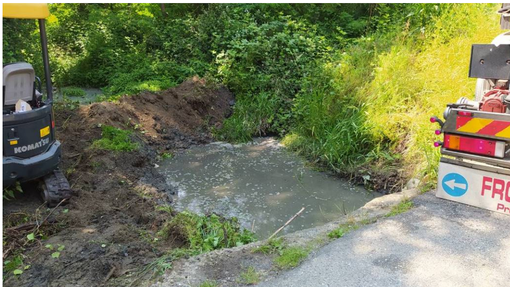
Foto 1 - Luogo dello sbarramento
