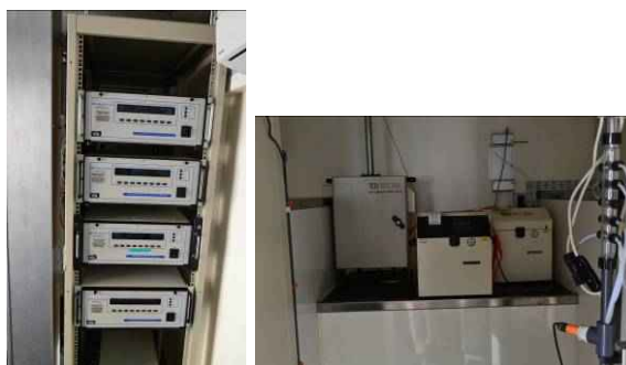
Figura 2: Mezzo mobile dell' ARPA Piemonte e strumentazione allestita
