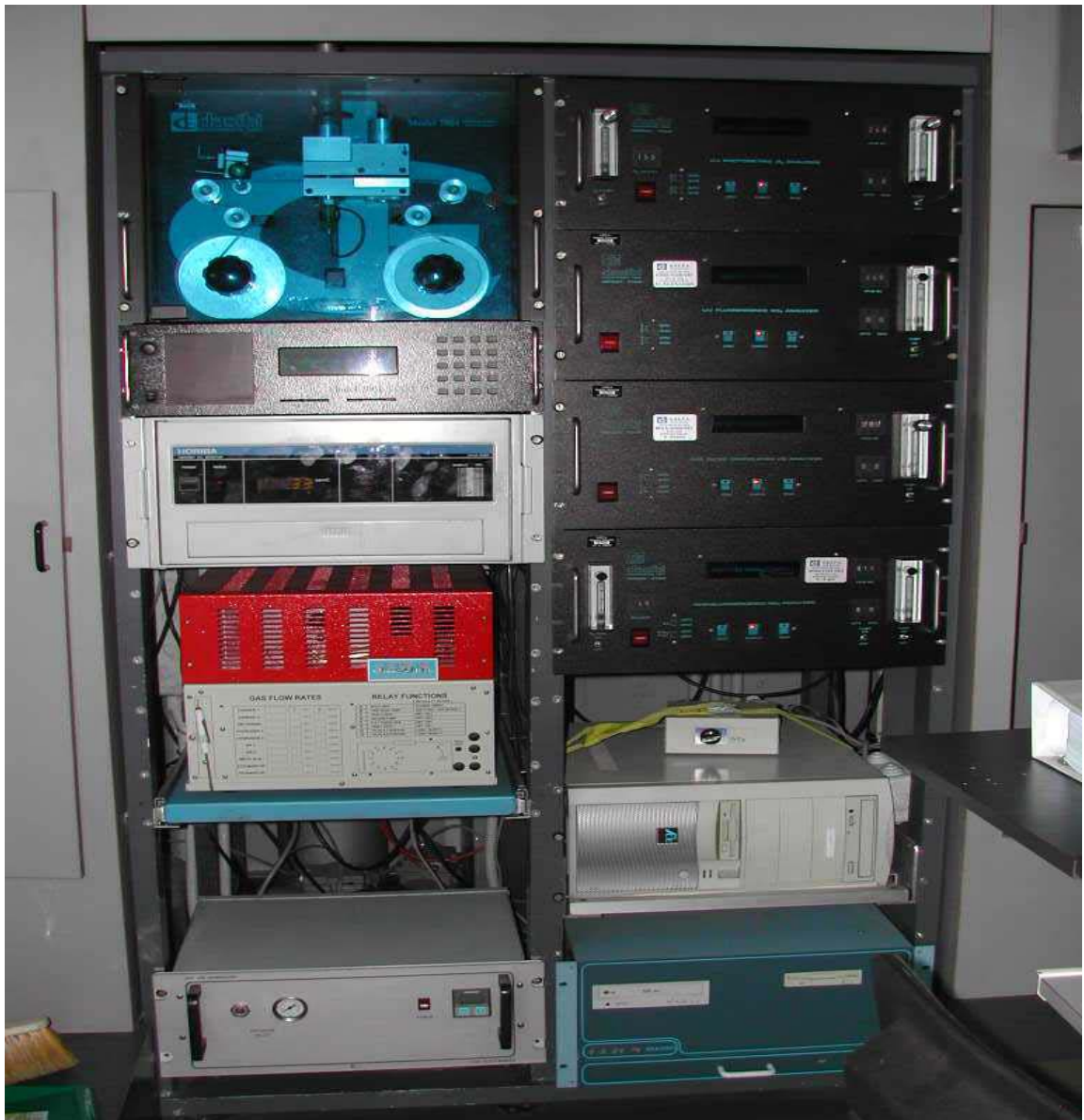
Figura 2: Strumentazione del laboratorio mobile
