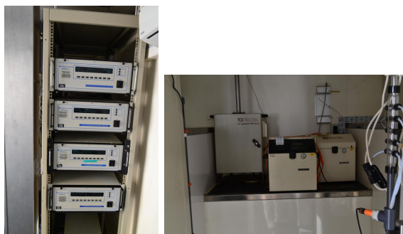
Figura 2: Mezzo mobile della Provincia di Novara nel sito e strumentazione allestita
