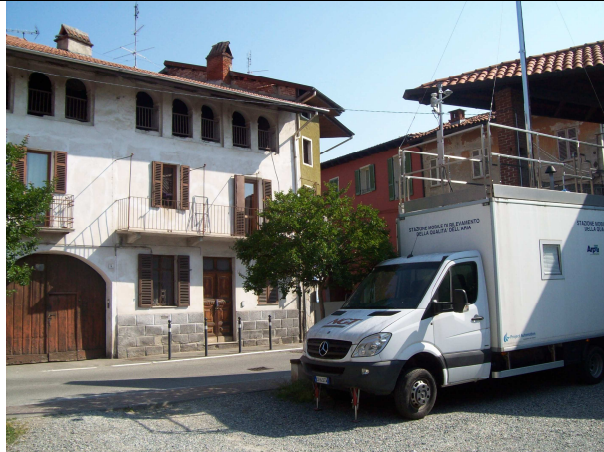
Visuale lato Nord
