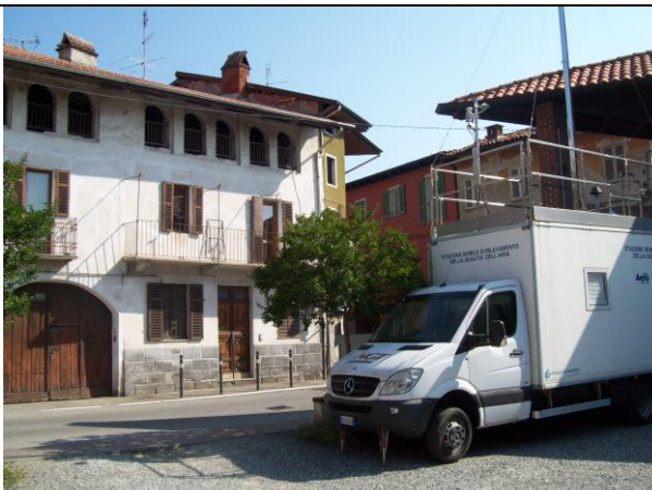
Visuale lato Nord
