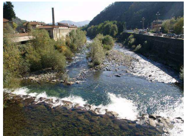
Vista verso valle dal ponte della strada provinciale a Coggiola
