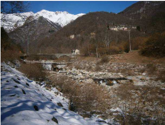
Il ponte Pinchiolo e la parte iniziale del tratto
