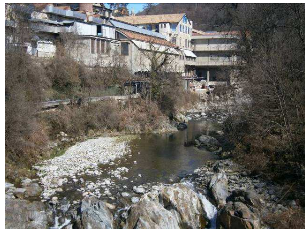
La parte terminale del tratto dal Ponte Filatura a Tollegno
